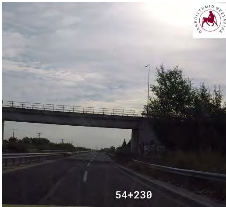
Χ.Θ. : 54+230 : Έλλειψη συνέχειας ασφάλισης & απαιτείται η τοποθέτηση στηθαίου
