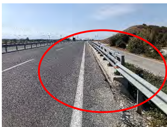
Χ.Θ. : 43+120 : Συναρμογές που δεν πληρούν τις προδιαγραφές & απαιτείται αποκατάσταση, καθώς επίσης διαμόρφωση του gutter και του ρείθρου
