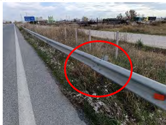
Χ.Θ. : 52+030 : Έλλειψη κοιλίων σύσφιξης & απαιτείται αποκατάσταση
