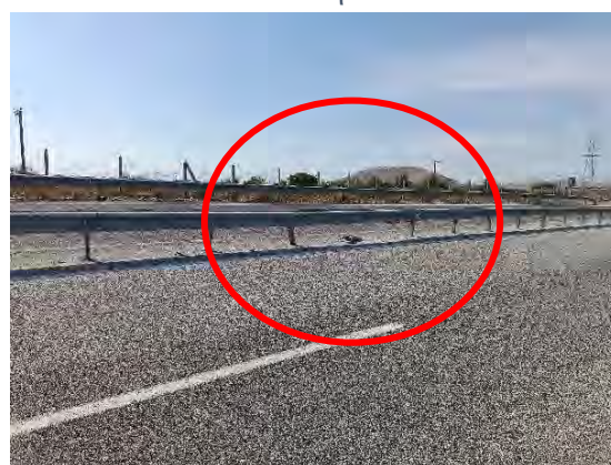
Χ.Θ. : 35+870 : Φθορά σε στηθαίο ασφαλείας & απαιτείται αποκατάσταση
