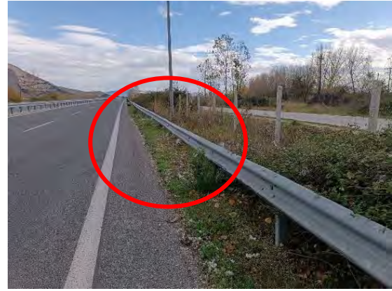
Χ.Θ. : 45+470 : Φθορά σε στηθαίο ασφαλείας & απαιτείται αποκατάσταση
