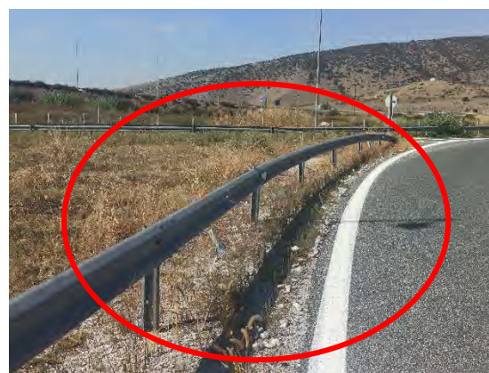
Εικόνες : Φθορά και αντίθετη φορά ορθοστατών σε στηθαίο ασφαλείας & απαιτείται αποκατάσταση, στον κλάδο εξόδου του Α/Κ Πετρόπορου, κατεύθυνση προς Τρίκαλα (Πηγή : Ιδία επεξεργασία)
