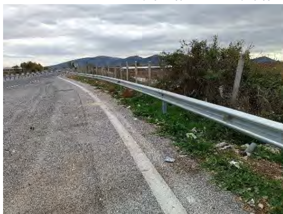
Χ.Θ. : 36+040 : Αντικατάσταση στηθαίου ασφαλείας που είχε υποστεί φθορά
