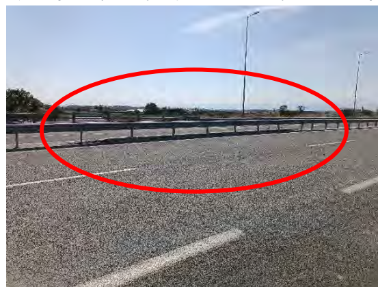
Χ.Θ. : 41+800 : Ακατάλληλος τύπος στηθαίου ασφαλείας & απαιτείται αποκατάσταση
