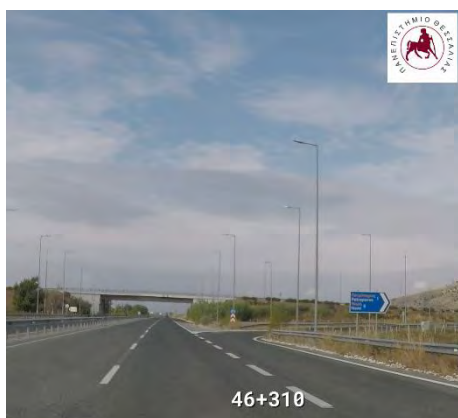
Χ.Θ. : 46+310 : Απαιτείται η τοποθέτηση Σ.Α.Ε.Π. & ευανάγνωστη σήμανση
