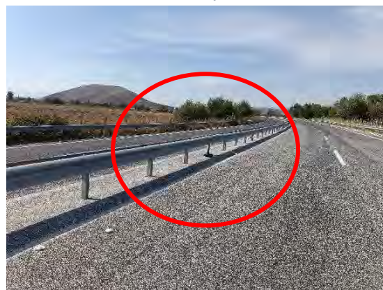
Χ.Θ. : 36+640 : Φθορά σε στηθαίο ασφαλείας & απαιτείται αποκατάσταση
