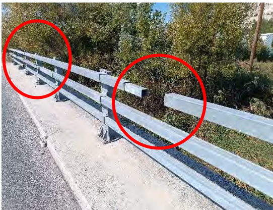
Χ.Θ. : 43+820 : Ελλείψεις τεμαχίων στηθαίου ασφαλείας & απαιτείται αποκατάσταση
