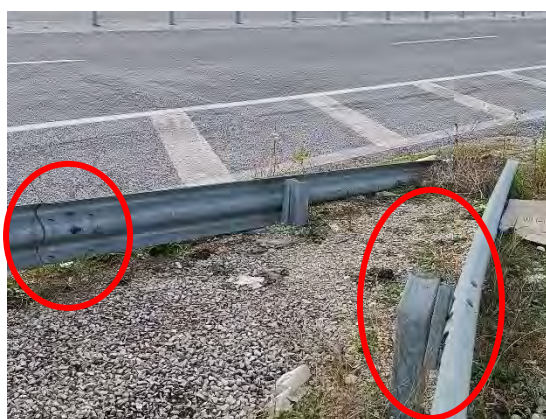
Εικόνα : Αποκατάσταση απόληξης ασφάλισης στον κλάδο εισόδου του Α/Κ Φαρκαδόνας, κατεύθυνση προς Τρίκαλα (Πηγή : Ιδία επεξεργασία)
