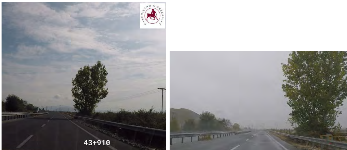
Εικόνες : Απορροή ομβρίων υδάτων σε καμπύλη συναρμογής – κατεύθυνση προς Λάρισα (Πηγή : Ιδία επεξεργασία)
