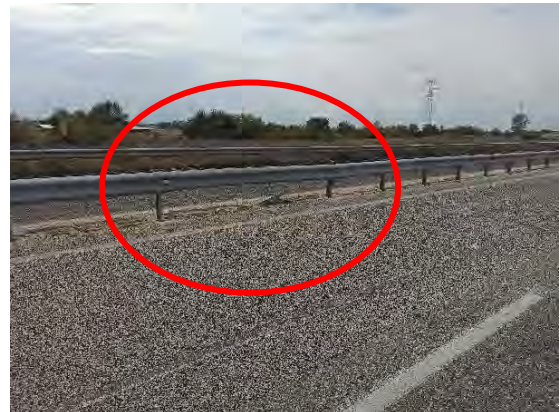
Χ.Θ. : 54+700 : Φθορά σε στηθαίο ασφαλείας & απαιτείται αποκατάσταση (κοπή βλάστησης)
