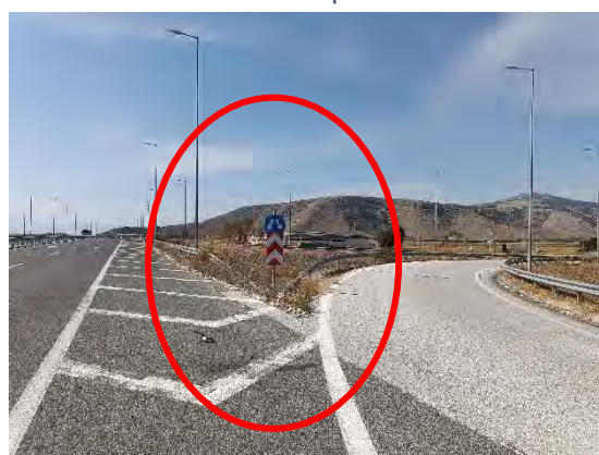
Χ.Θ. : 41+640 : Απαιτείται η τοποθέτηση Σ.Α.Ε.Π. & ευανάγνωστη σήμανση
