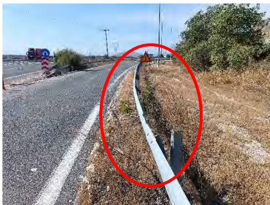
Εικόνες : Φθορά σε στηθαίο ασφαλείας & απαιτείται αποκατάσταση, στον κλάδο εξόδου του Η/Κ Φαρκαδόνας, κατεύθυνση προς Τρίκαλα (Πηγή : Ιδία επεξεργασία)
