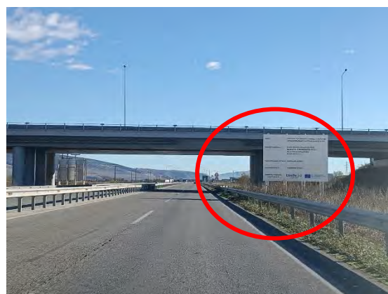
Χ.Θ. : 56+970 : Απαιτείται περαιτέρω ασφάλιση της οδού, λόγω πλευρικού εμποδίου
