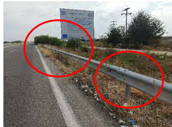
Χ.Θ. : 53+890 : Απαιτείται περαιτέρω ασφάλιση της οδού, λόγω πλευρικού εμποδίου
