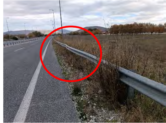
Χ.Θ. : 41+580 : Φθορά σε στηθαίο ασφαλείας & απαιτείται αποκατάσταση
