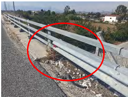
Χ.Θ. : 50+330 : Συναρμογές που δεν πληρούν τις προδιαγραφές & απαιτείται αποκατάσταση
