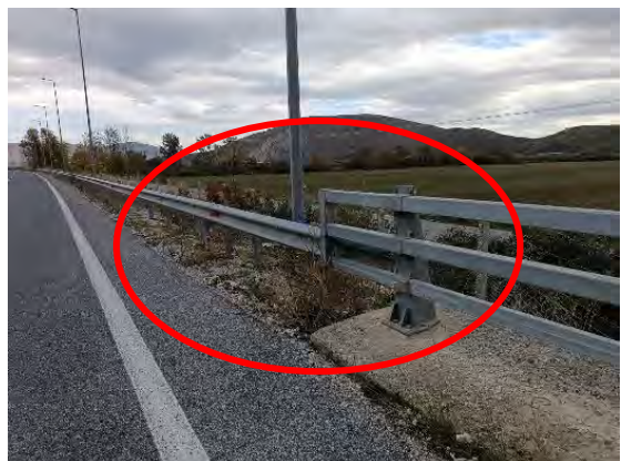
Χ.Θ. : 40+350 : Συναρμογές που δεν πληρούν τις προδιαγραφές & απαιτείται αποκατάσταση
