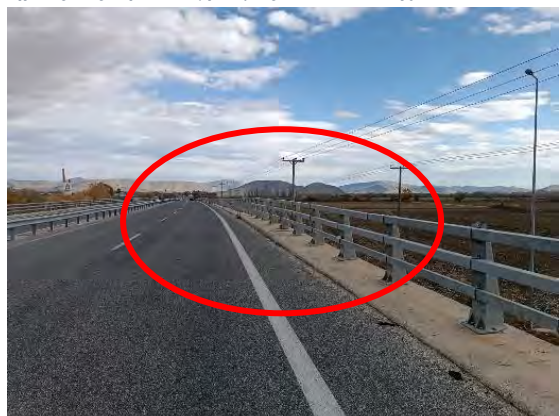
Χ.Θ. : 43+400 : Ανομοιόμορφο κράσπεδο ως προς το ύψος & απαιτείται αποκατάσταση
