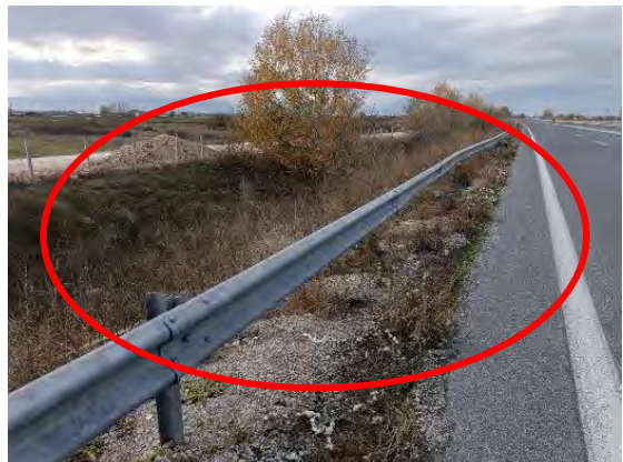
Χ.Θ. : 47+340 : Φθορά σε στηθαίο ασφαλείας & απαιτείται αποκατάσταση
