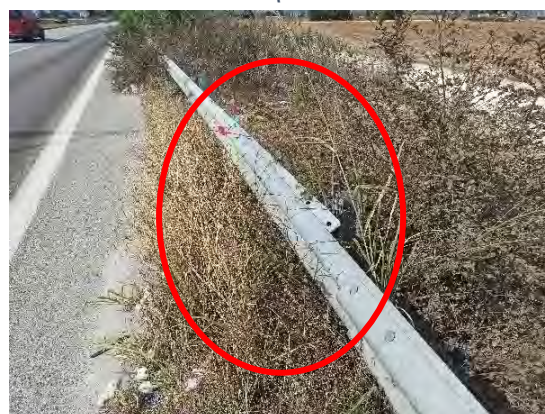
Χ.Θ. : 53+170 : Συναρμογή μη σύμφωνη με τις προδιαγραφές & απαιτείται αποκατάσταση
