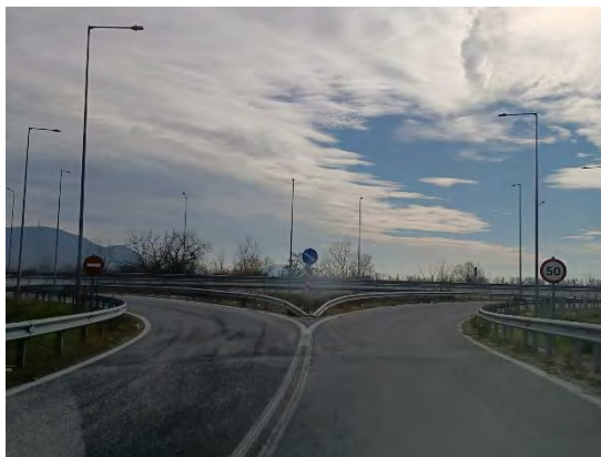
Εικόνα : Τοποθέτηση Σ.Α.Ε.Π. & ευανάγνωστης σήμανσης στον κλάδο εισόδου του Α/Κ Φαρκαδόνας, κατεύθυνση προς Τρίκαλα (Πηγή : Ιδία επεξεργασία)
