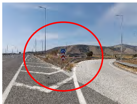
Χ.Θ. : 46+310 : Απαιτείται η τοποθέτηση Σ.Α.Ε.Π. & ευανάγνωστη σήμανση
