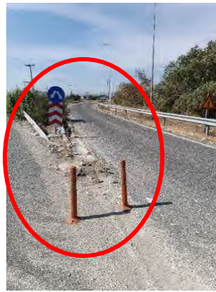
Χ.Θ. : 33+200 : Απαιτείται η τοποθέτηση Σ.Α.Ε.Π. & ευανάγνωστη σήμανση
