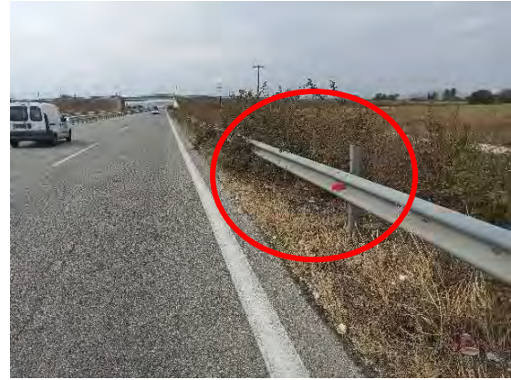
Χ.Θ. : 55+250 : Συναρμογή μη σύμφωνη με τις προδιαγραφές & απαιτείται αποκατάσταση
