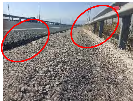
Χ.Θ. : 50+470 : Φθορά σε στηθαίο ασφαλείας & απαιτείται αποκατάσταση (έλεγχος gutter)
