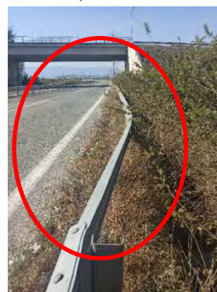
Χ.Θ. : 53+800 : Έλλειψη κοιλίων σύσφιξης & απαιτείται αφαίρεση παλαιών ορθοστατών
