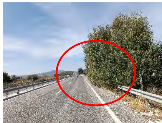
Χ.Θ. : 36+320 : Απαιτείται κλαδοκοπή για εποπτεία της ασφάλισης
