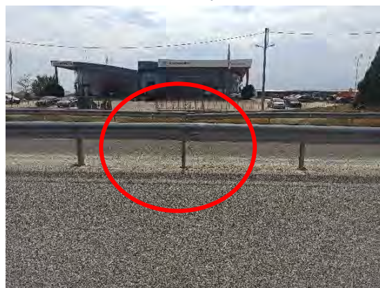
Χ.Θ. : 55+900 : Έλλειψη κοιλίων σύσφιξης & απαιτείται αποκατάσταση (ορθοστάτης)
