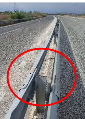
Χ.Θ. : 54+350 : Αντίθετη φορά λεπίδας, έλλειψη κοχλίων σύσφιξης & απαιτείται αποκατάσταση
