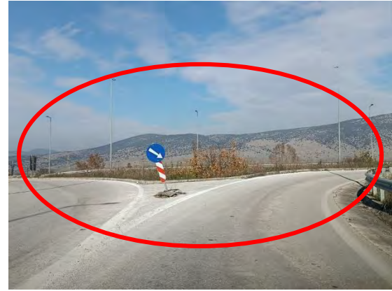
Εικόνες : Κατάργηση της κρασπεδωμένης τριγωνικής νησίδας, τοποθέτηση ασφάλισης, Σ.Α.Ε.Π. & ευανάγνωστης σήμανσης, στους κλάδους εξόδου – εισόδου του Α/Κ Ταξιαρχών, κατεύθυνση προς Λάρισα (Πηγή : Ιδία επεξεργασία)
