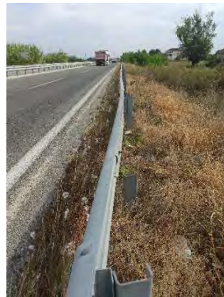
Χ.Θ. : 53+730 : Φθορά σε στηθαίο ασφαλείας, έλλειψη κοιλίων & απαιτείται αποκατάσταση
