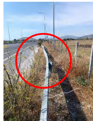
Χ.Θ. : 34+230 : Απαιτείται η τοποθέτηση Σ.Α.Ε.Π. & ευανάγνωστη σήμανση
