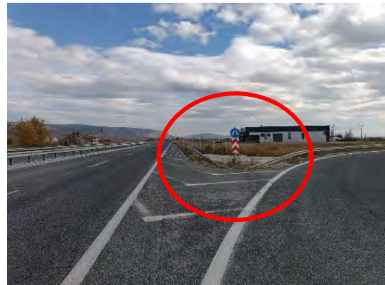
Χ.Θ. : 48+470 : Απαιτείται η τοποθέτηση Σ.Α.Ε.Π. & ευανάγνωστη σήμανση
