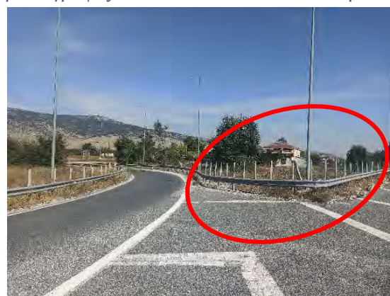
Χ.Θ. : 50+660 : Συναρμογή μη σύμφωνη με τις προδιαγραφές & απαιτείται αποκατάσταση
