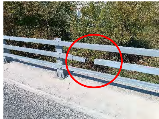
Χ.Θ. : 43+820 : Ελλείψεις τεμαχίων στηθαίου ασφαλείας & απαιτείται αποκατάσταση
