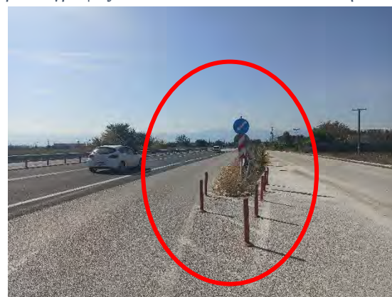
Χ.Θ. : 52+500 : Απαιτείται η τοποθέτηση Σ.Α.Ε.Π. & ευανάγνωστη σήμανση
