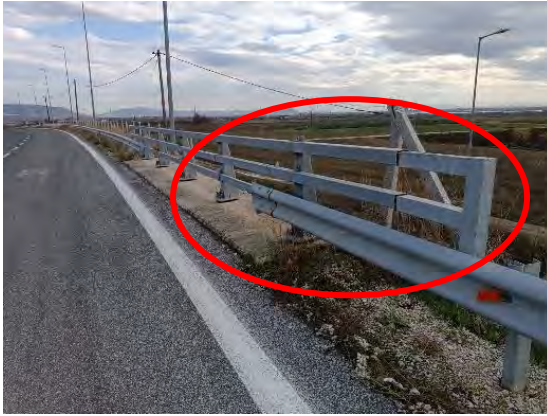
Χ.Θ. : 50+400 : Συναρμογές που δεν πληρούν τις προδιαγραφές & απαιτείται αποκατάσταση
