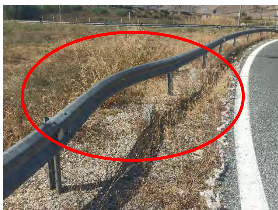
Εικόνες : Φθορά και αντίθετη φορά ορθοστατών σε στηθαίο ασφαλείας & απαιτείται αποκατάσταση, στον κλάδο εξόδου του Α/Κ Πετρόπορου, κατεύθυνση προς Τρίκαλα (Πηγή : Ιδία επεξεργασία)
