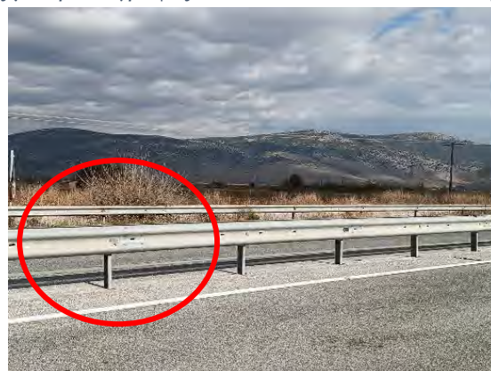
Χ.Θ. : 52+500 : Συναρμογή μη σύμφωνη πλήρως με προδιαγραφές & απαιτείται αποκατάσταση
