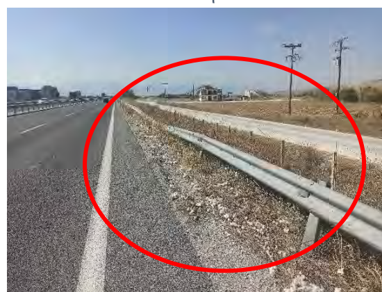
Χ.Θ. : 48+040 : Φθορά σε στηθαίο ασφαλείας & απαιτείται αποκατάσταση
