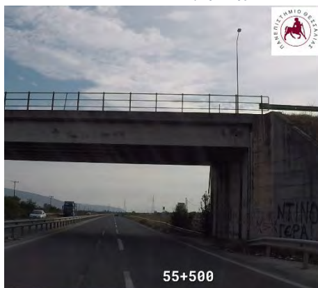
Χ.Θ. : 55+500 : Έλλειψη συνέχειας ασφάλισης & απαιτείται η τοποθέτηση στηθαίου ασφαλείας
