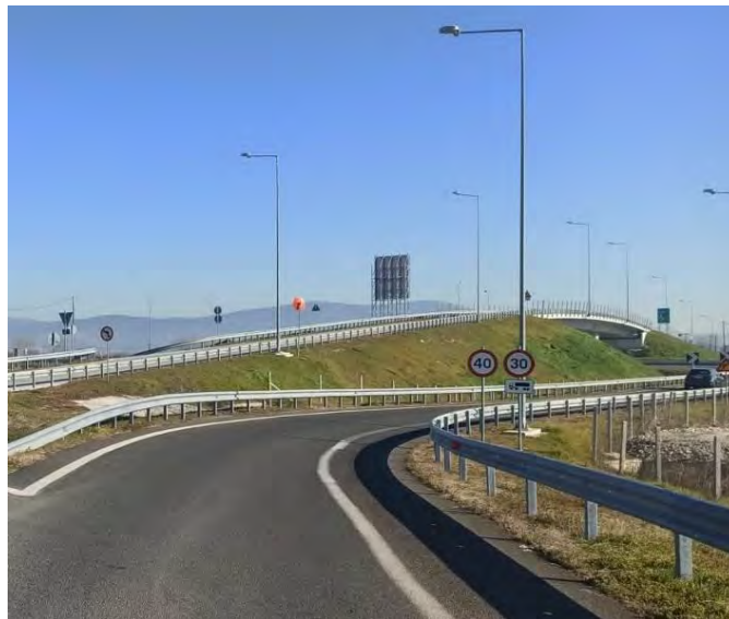
Εικόνα : Πρόταση πρόσθετης σήμανσης για μείωση ταχύτητας βαρέων οχημάτων σε κλάδους κόμβων (Πηγή : Ιδία επεξεργασία)
