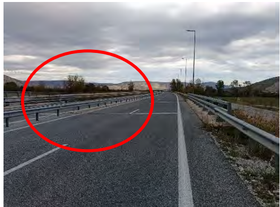
Χ.Θ. : 40+350 : Ακατάλληλος τύπος στηθαίου ασφαλείας & απαιτείται αποκατάσταση
