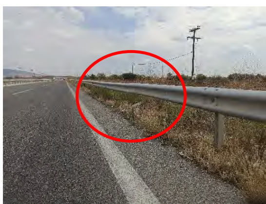
Χ.Θ. : 55+930 : Φθορά σε στηθαίο ασφαλείας & απαιτείται αποκατάσταση
