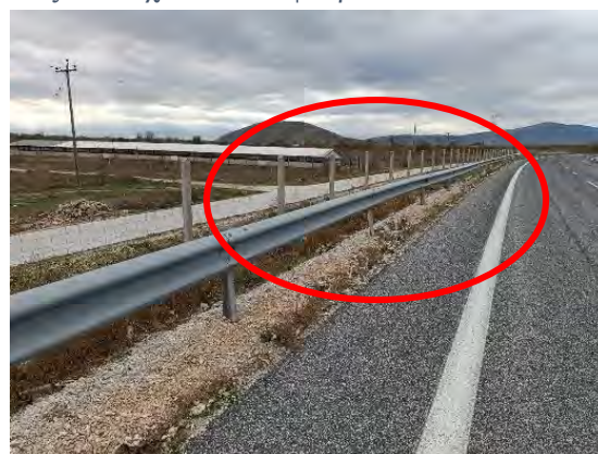
Χ.Θ. : 35+790 : Φθορά σε στηθαίο ασφαλείας & απαιτείται αποκατάσταση
