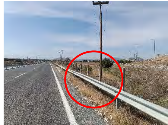
Χ.Θ. : 33+280 : Φθορά σε στηθαίο ασφαλείας & απαιτείται αποκατάσταση
