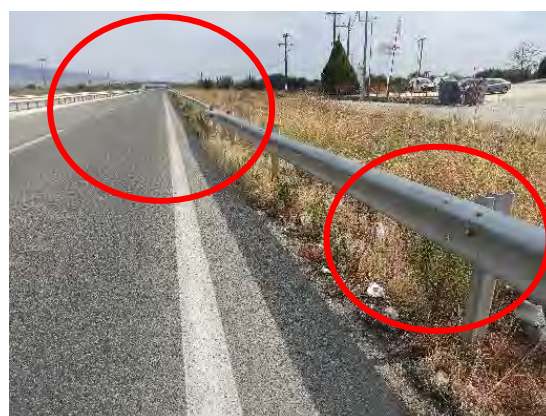
Χ.Θ. : 55+960 : Φθορά σε στηθαίο ασφαλείας, έλλειψη κοχλίων & απαιτείται αποκατάσταση
