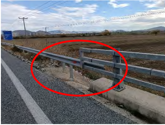
Χ.Θ. : 43+400 : Συναρμογές που δεν πληρούν τις προδιαγραφές & απαιτείται αποκατάσταση
