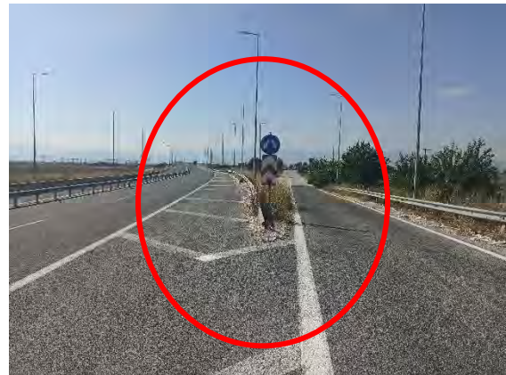
Χ.Θ. : 49+800 : Απαιτείται η τοποθέτηση Σ.Α.Ε.Π., ασφάλισης & ευανάγνωστη σήμανση
