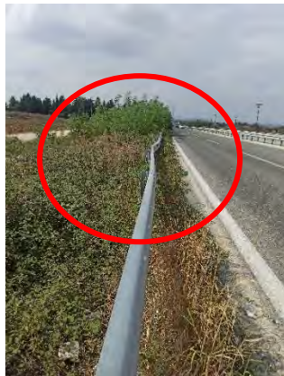
Χ.Θ. : 53+730 : Φθορά σε στηθαίο ασφαλείας, έλλειψη κοιλίων & απαιτείται αποκατάσταση
