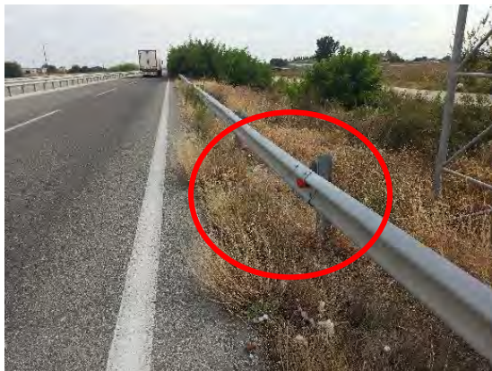
Χ.Θ. : 53+890 : Αντίθετη φορά λεπίδας, έλλειψη κοχλίων σύσφιξης & απαιτείται αποκατάσταση
