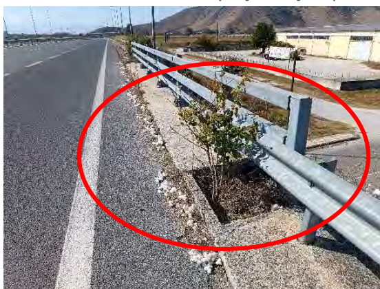
Χ.Θ. : 41+800 : Συναρμογές που δεν πληρούν τις προδιαγραφές & απαιτείται αποκατάσταση
