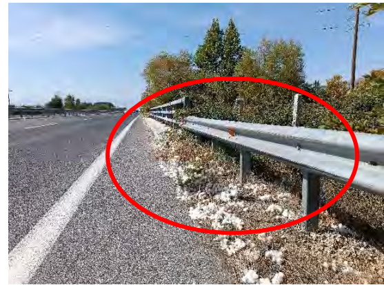
Χ.Θ. : 43+820 : Φθορά σε στηθαίο ασφαλείας & απαιτείται αποκατάσταση
