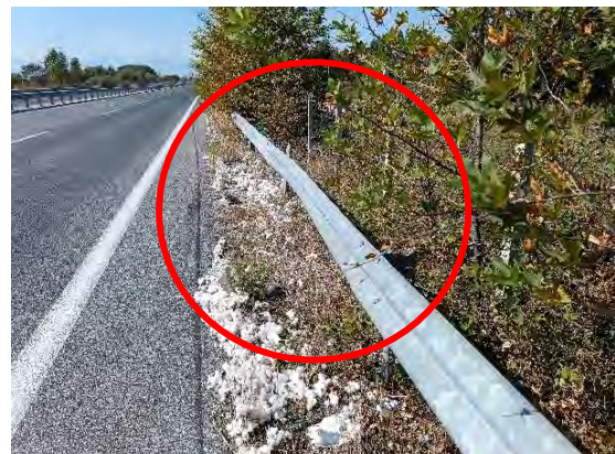
Χ.Θ. : 43+860 : Φθορά σε στηθαίο ασφαλείας & απαιτείται αποκατάσταση
