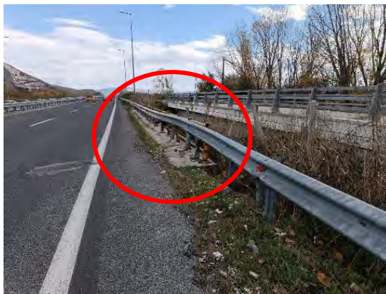
Χ.Θ. : 45+540 : Φθορά & ακατάλληλος τύπος στηθαίου ασφαλείας & απαιτείται αποκατάσταση
