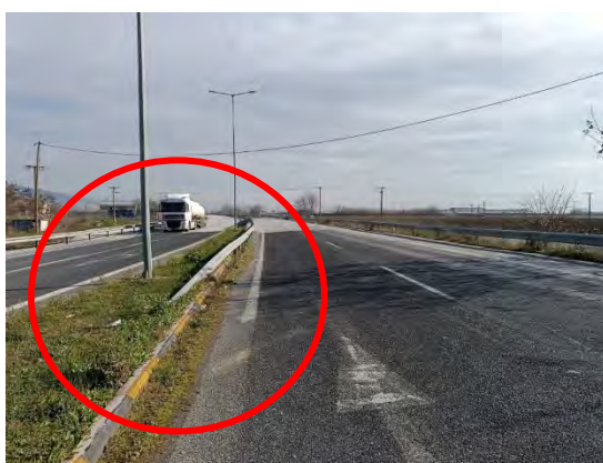
Εικόνες : Επέκταση της ασφάλισης με τον κατάλληλο τύπο στηθαίου ασφαλείας και με τη διαμόρφωση απολήξεων, σύμφωνα με τις προδιαγραφές, στον Ι/Κ Μεγαλοχωρίου (Πηγή : Ιδία επεξεργασία)
