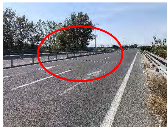
Χ.Θ. : 40+060 : Ακατάλληλος τύπος στηθαίου ασφαλείας & απαιτείται αποκατάσταση
