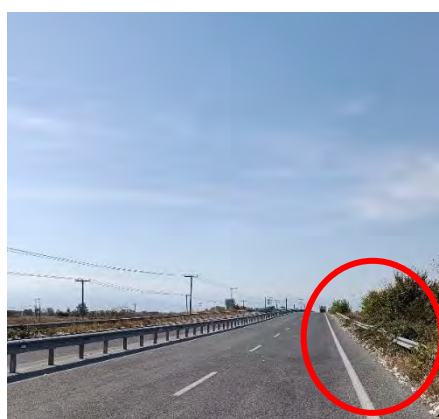
Χ.Θ. : 43+000 : Φθορά σε στηθαίο ασφαλείας & απαιτείται αποκατάσταση
