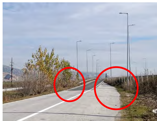
Εικόνες : Φθορά σε στηθαίο ασφαλείας & απαιτείται αποκατάσταση (αριστερά) και επέκταση της ασφάλισης με τη διαμόρφωση απολήξεων, σύμφωνα με τις προδιαγραφές (δεξιά), στον κλάδο εξόδου του Α/Κ Ταξιαρχών, κατεύθυνση προς Τρίκαλα (Πηγή : Ιδία επεξεργασία)
