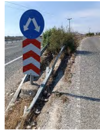
Χ.Θ. : 33+200 : Απαιτείται η τοποθέτηση Σ.Α.Ε.Π. & ευανάγνωστη σήμανση
