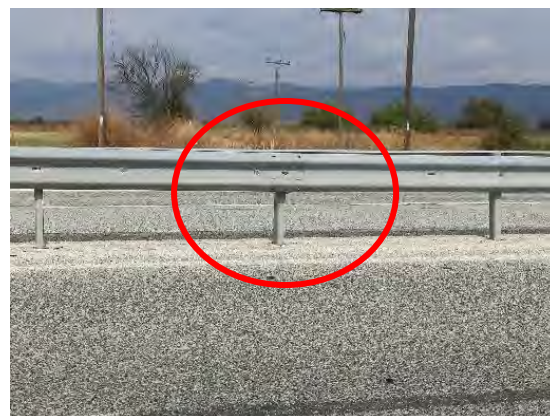
Χ.Θ. : 55+700 : Έλλειψη κοιλίων σύσφιξης & απαιτείται αποκατάσταση
