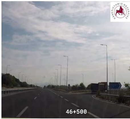
Χ.Θ. : 46+500 : Απαιτείται η τοποθέτηση Σ.Α.Ε.Π. & ευανάγνωστη σήμανση
