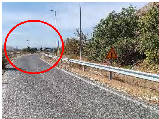
Εικόνες : Φθορά σε στηθαίο ασφαλείας & απαιτείται αποκατάσταση, στον κλάδο εξόδου του Η/Κ Φαρκαδόνας, κατεύθυνση προς Τρίκαλα (Πηγή : Ιδία επεξεργασία)
