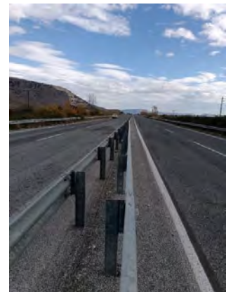
Χ.Θ. : 45+540 : Παρατηρείται ανισοσταθμία των δύο κλάδων, στο ύψος της γέφυρας
