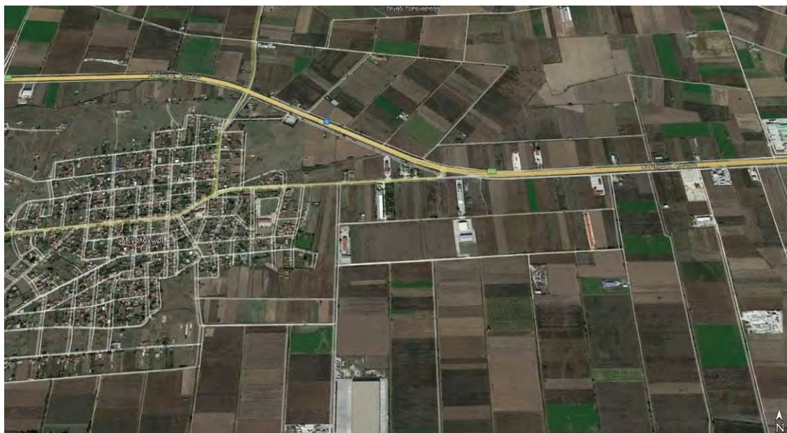
Σχήμα 11 : I/K Μεγαλοχωρίου – Χ.Θ. : 53+100 (Πηγή : Google Earth – Ιδία επεξεργασία)
