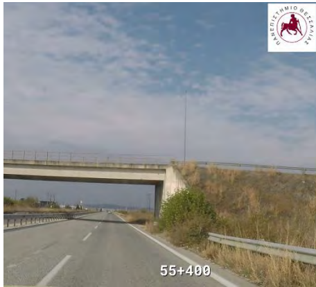
Χ.Θ. : 55+400 : Έλλειψη κοιλίων σύσφιξης & απαιτείται η συνέχεια της ασφάλισης
