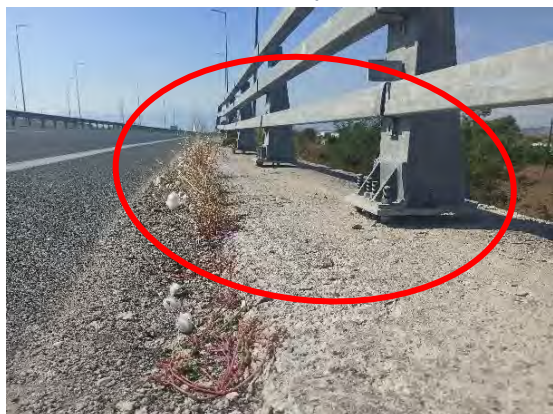
Χ.Θ. : 50+330 : Έκθεση αγκυρίων έδρασης στηθαίου ασφαλείας & απαιτείται αποκατάσταση
