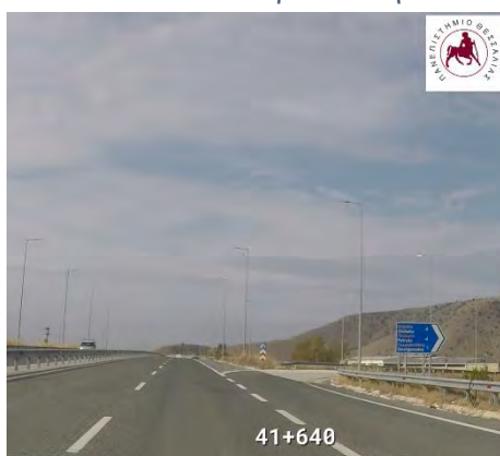
Χ.Θ. : 41+640 : Απαιτείται η τοποθέτηση Σ.Α.Ε.Π. & ευανάγνωστη σήμανση
