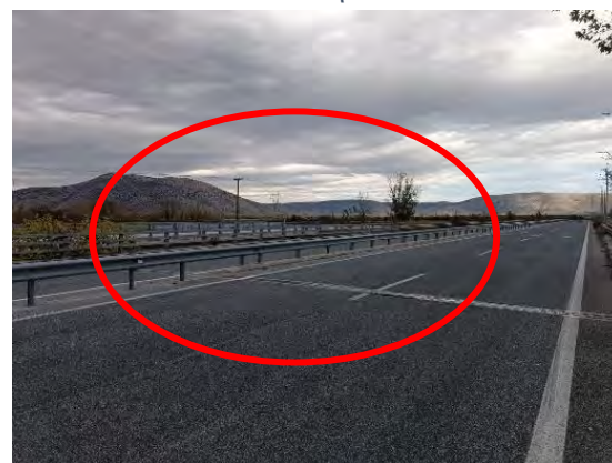
Χ.Θ. : 40+140 : Ακατάλληλος τύπος στηθαίου ασφαλείας & απαιτείται αποκατάσταση
