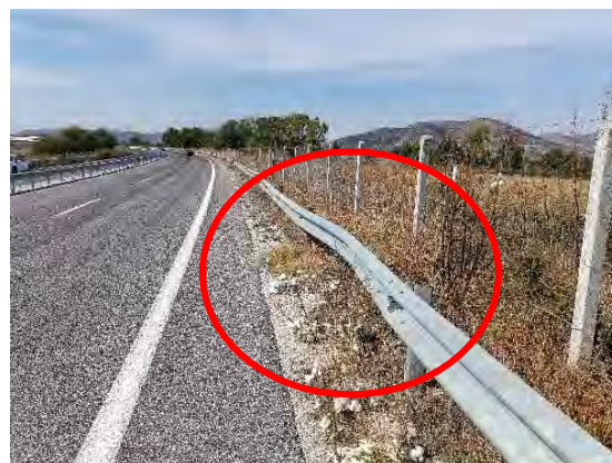
Χ.Θ. : 36+600 : Φθορά σε στηθαίο ασφαλείας & απαιτείται αποκατάσταση
