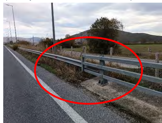
Χ.Θ. : 40+140 : Συναρμογές που δεν πληρούν τις προδιαγραφές & απαιτείται αποκατάσταση
