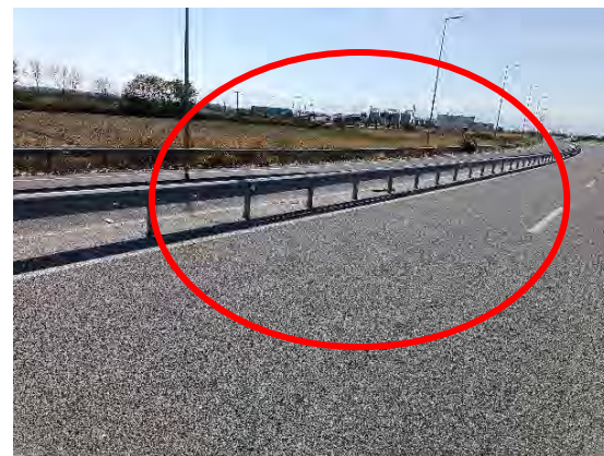
Χ.Θ. : 42+110 : Έλλειψη κοιλίων στηθαίου ασφαλείας & απαιτείται αποκατάσταση
