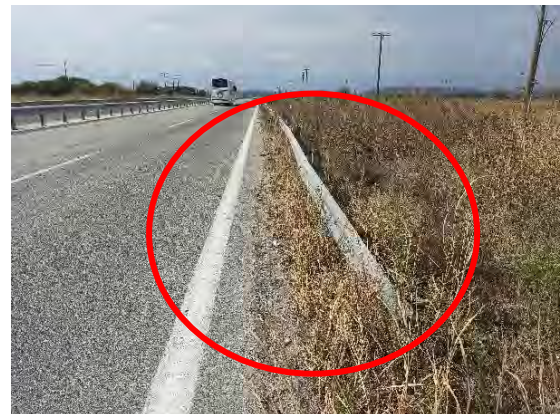
Χ.Θ. : 55+400 : Φθορά σε στηθαίο ασφαλείας & απαιτείται η συνέχεια της ασφάλισης
