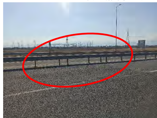
Χ.Θ. : 50+650 : Συναρμογή μη σύμφωνη με τις προδιαγραφές & απαιτείται αποκατάσταση
