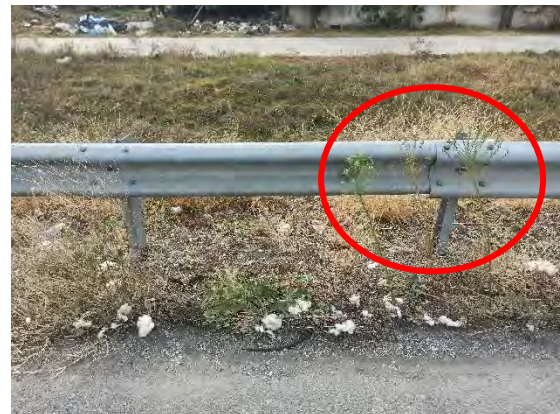
Χ.Θ. : 53+890 : Αντίθετη φορά λεπίδας, έλλειψη κοχλίων σύσφιξης & απαιτείται αποκατάσταση
