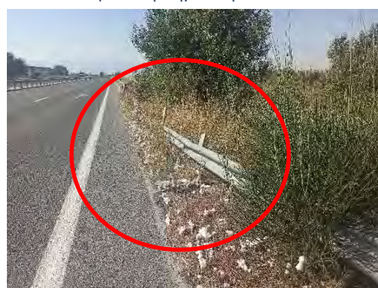
Χ.Θ. : 47+910 : Φθορά σε στηθαίο ασφαλείας & απαιτείται αποκατάσταση
