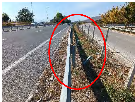
Χ.Θ. : 40+650 : Απαιτείται αφαίρεση των παλαιών ορθοστατών
