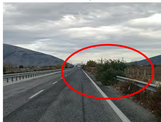
Χ.Θ. : 35+270 : Απαιτείται κοπή της βλάστησης για εποπτεία της ασφάλισης
