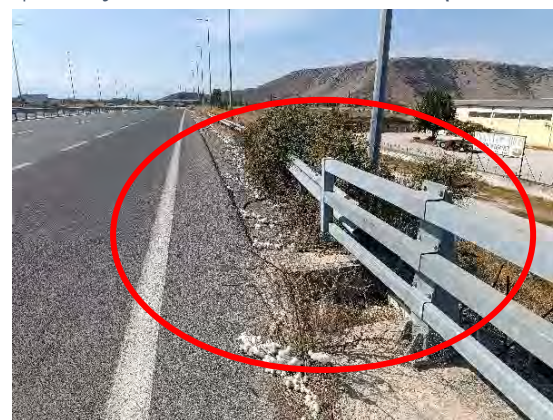
Χ.Θ. : 41+800 : Συναρμογές που δεν πληρούν τις προδιαγραφές & απαιτείται αποκατάσταση
