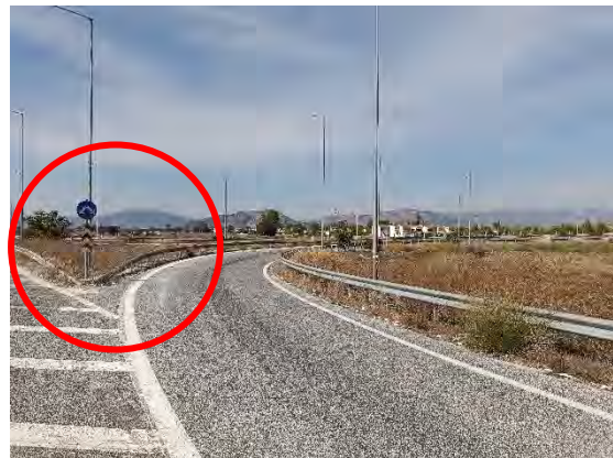
Χ.Θ. : 34+230 : Απαιτείται η τοποθέτηση Σ.Α.Ε.Π. & ευανάγνωστη σήμανση
