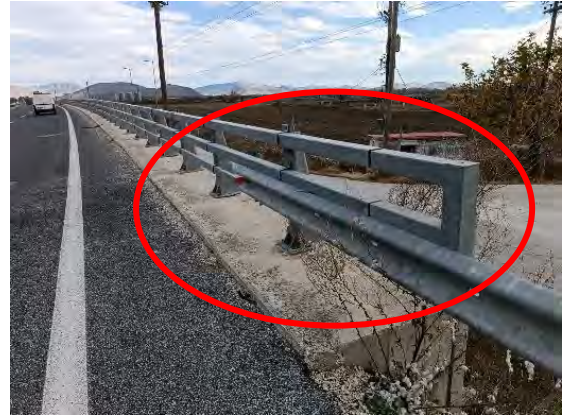
Χ.Θ. : 43+400 : Συναρμογές που δεν πληρούν τις προδιαγραφές & απαιτείται αποκατάσταση
