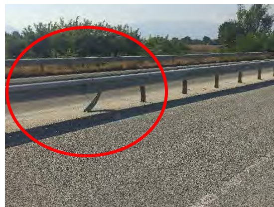
Χ.Θ. : 53+450 : Φθορά σε στηθαίο ασφαλείας & απαιτείται αποκατάσταση
