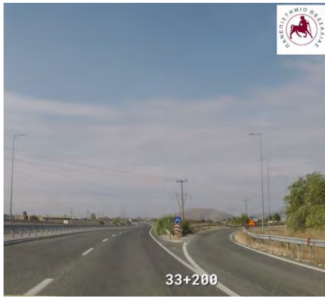
Χ.Θ. : 33+200 : Απαιτείται η τοποθέτηση Σ.Α.Ε.Π. & ευανάγνωστη σήμανση
