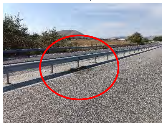
Χ.Θ. : 36+530 : Φθορά σε στηθαίο ασφαλείας & απαιτείται αποκατάσταση, περισυλλογή ζώου
