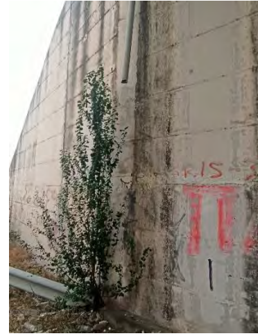
Εικόνες : Φθορά συστήματος αποχέτευσης τεχνικού άνω διάβασης, κατεύθυνση προς Λάρισα (Πηγή : Ιδία επεξεργασία)
