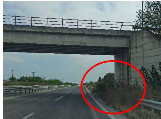
Χ.Θ. : 54+230 : Έλλειψη συνέχειας ασφάλισης & απαιτείται η τοποθέτηση στηθαίου
