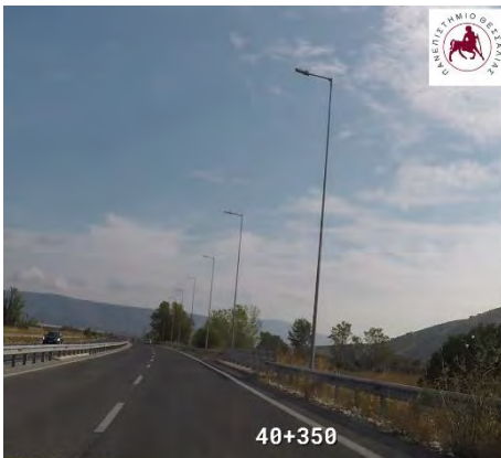
Χ.Θ. : 40+350 : Ακατάλληλος τύπος στηθαίου ασφαλείας & απαιτείται αποκατάσταση
