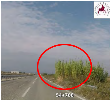
Χ.Θ. : 54+700 : Φθορά σε στηθαίο ασφαλείας & απαιτείται αποκατάσταση (κοπή βλάστησης)
