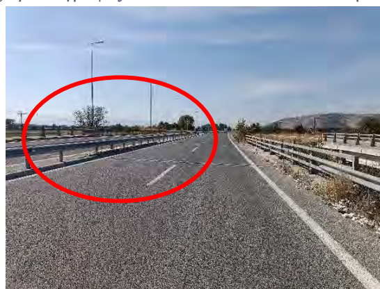
Χ.Θ. : 40+260 : Ακατάλληλος τύπος στηθαίου ασφαλείας & απαιτείται αποκατάσταση
