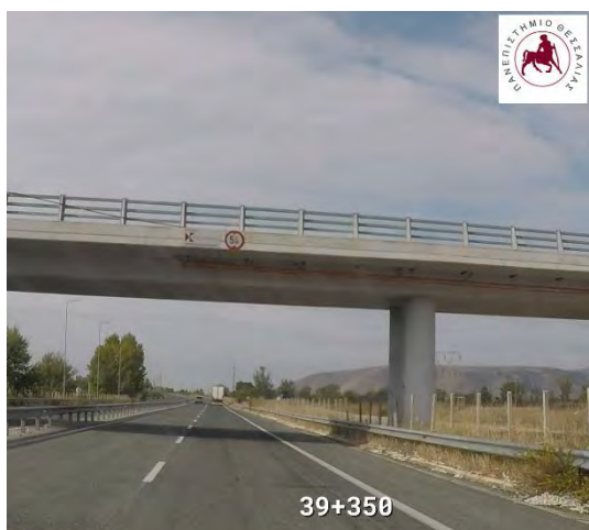
Εικόνες : Αναγραφή ελεύθερου ύψους άνω διάβασης, κατεύθυνση προς Τρίκαλα (αριστερά) και προς Λάρισα (δεξιά) (Πηγή : Ιδία επεξεργασία)
