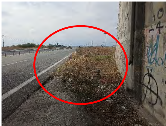
Χ.Θ. : 55+400 : Φθορά σε στηθαίο ασφαλείας & απαιτείται η συνέχεια της ασφάλισης
