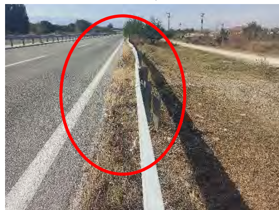
Χ.Θ. : 53+800 : Φθορά σε στηθαίο ασφαλείας & απαιτείται αποκατάσταση
