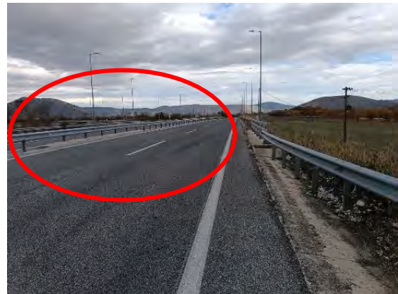
Χ.Θ. : 41+860 : Ακατάλληλος τύπος στηθαίου ασφαλείας & απαιτείται αποκατάσταση
