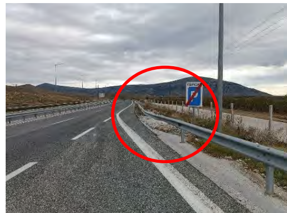
Χ.Θ. : 33+140 : Φθορά σε στηθαίο ασφαλείας & απαιτείται αποκατάσταση
