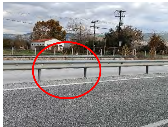
Χ.Θ. : 52+700 : Συναρμογή μη σύμφωνη πλήρως με προδιαγραφές & απαιτείται αποκατάσταση
