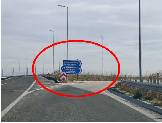
Εικόνες : Κατάργηση της κρασπεδωμένης τριγωνικής νησίδας, τοποθέτηση ασφάλισης, Σ.Α.Ε.Π. & ευανάγνωστης σήμανσης, στους κλάδους εξόδου – εισόδου του Α/Κ Ταξιαρχών, κατεύθυνση προς Λάρισα (Πηγή : Ιδία επεξεργασία)
