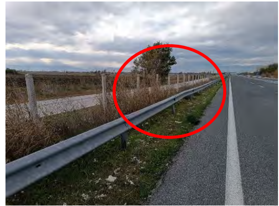
Χ.Θ. : 45+770 : Φθορά σε στηθαίο ασφαλείας & απαιτείται αποκατάσταση
