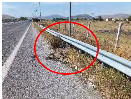
Χ.Θ. : 34+570 : Φθορά σε στηθαίο ασφαλείας & απαιτείται αποκατάσταση, περισυλλογή ζώου
