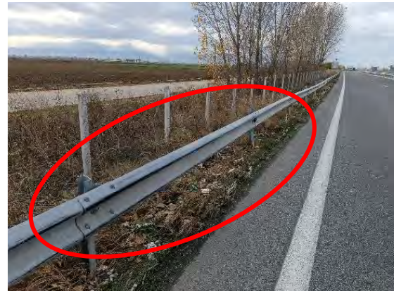
Χ.Θ. : 48+870 : Φθορά σε στηθαίο ασφαλείας & απαιτείται αποκατάσταση
