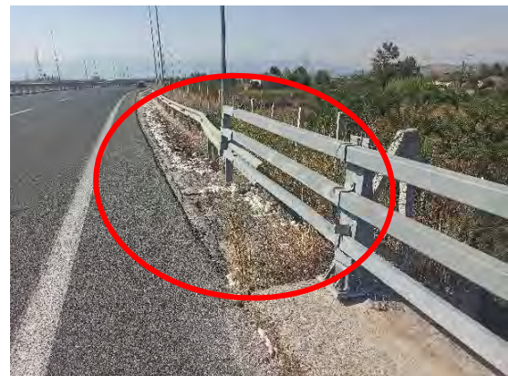
Χ.Θ. : 50+330 : Συναρμογές που δεν πληρούν τις προδιαγραφές & απαιτείται αποκατάσταση
