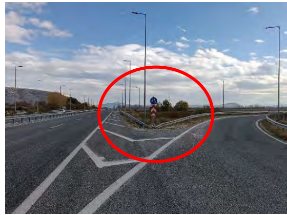
Χ.Θ. : 46+500 : Απαιτείται η τοποθέτηση Σ.Α.Ε.Π. & ευανάγνωστη σήμανση
