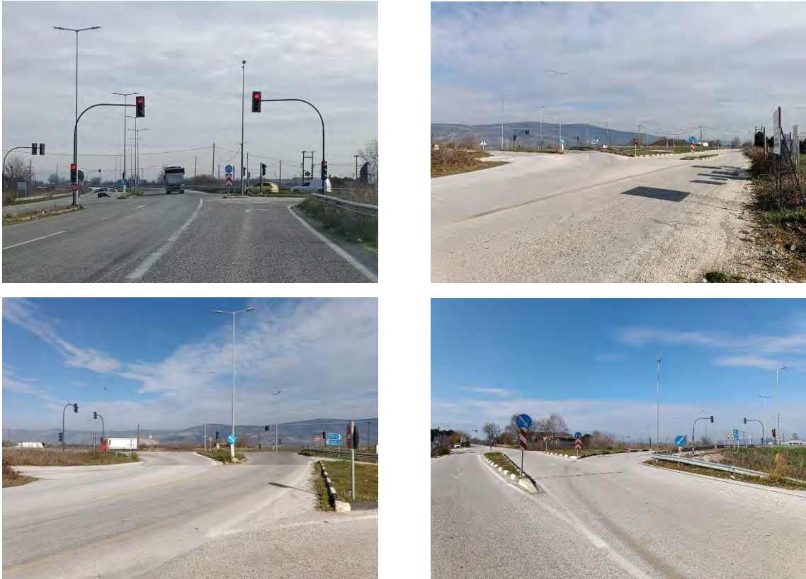
Εικόνες : Υφιστάμενη ισόπεδη σύνδεση με δευτερεύουσα οδό – κατεύθυνση προς Λάρισα (Πηγή : Ίδια επεξεργασία)
