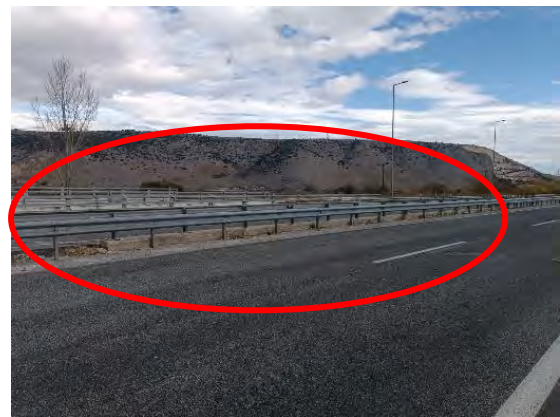
Χ.Θ. : 45+540 : Φθορά & ακατάλληλος τύπος στηθαίου ασφαλείας & απαιτείται αποκατάσταση
