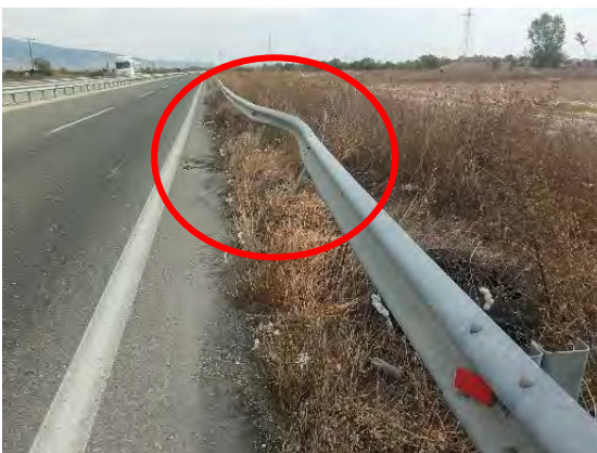
Χ.Θ. : 55+200 : Φθορά σε στηθαίο ασφαλείας & απαιτείται αποκατάσταση
