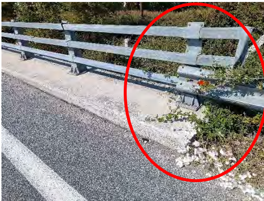
Χ.Θ. : 43+820 : Συναρμογές που δεν πληρούν τις προδιαγραφές & απαιτείται αποκατάσταση
