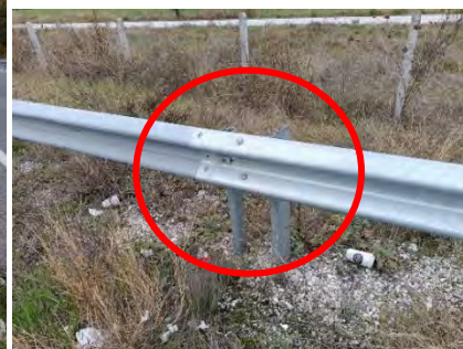
Χ.Θ. : 38+520 : Έλλειψη κοιλίων, απαιτείται αποκατάσταση & αφαίρεση παλαιών ορθοστατών
