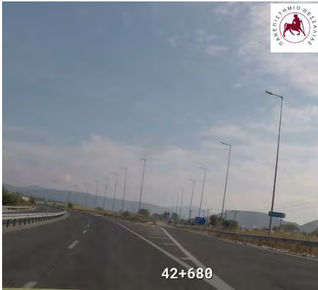
Χ.Θ. : 42+680 : Απαιτείται η τοποθέτηση Σ.Α.Ε.Π. & ευανάγνωστη σήμανση
