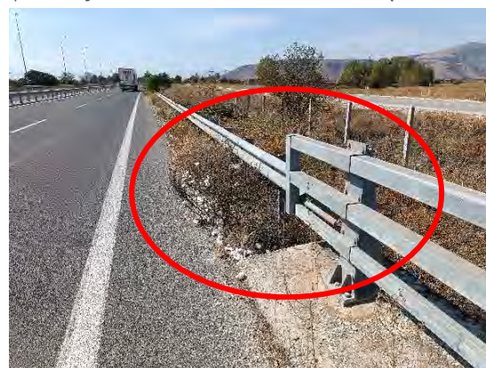
Χ.Θ. : 40+060 : Συναρμογές που δεν πληρούν τις προδιαγραφές & απαιτείται αποκατάσταση
