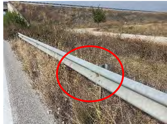
Χ.Θ. : 55+400 : Έλλειψη κοιλίων σύσφιξης & απαιτείται η συνέχεια της ασφάλισης
