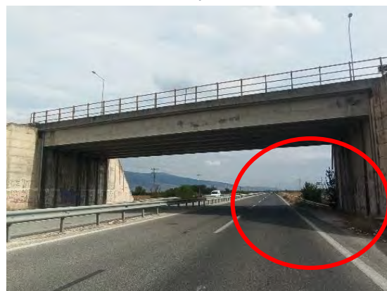
Χ.Θ. : 55+500 : Έλλειψη συνέχειας ασφάλισης & απαιτείται η τοποθέτηση στηθαίου ασφαλείας
