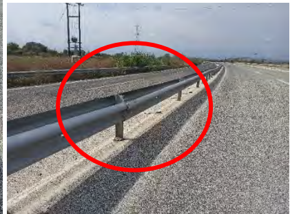
Χ.Θ. : 54+350 : Αντίθετη φορά λεπίδας, έλλειψη κοχλίων σύσφιξης & απαιτείται αποκατάσταση
