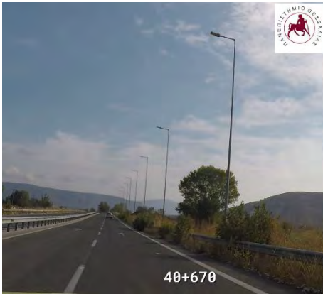
Χ.Θ. : 40+670 : Απαιτείται κοπή της βλάστησης για εποπτεία της ασφάλισης
