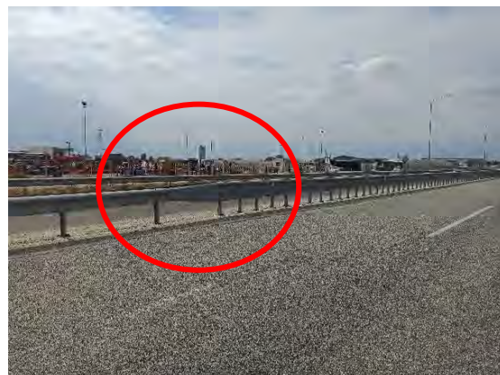
Χ.Θ. : 55+990 : Συναρμογή διαφορετικών τύπων στηθαίων (EN 1317)
