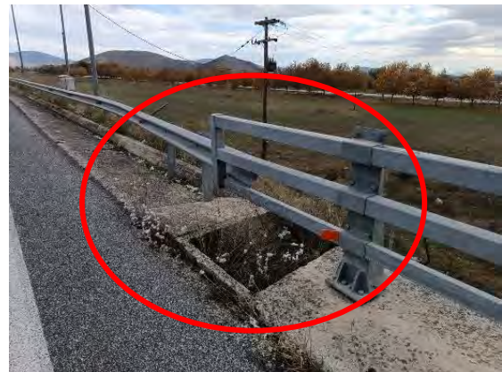
Χ.Θ. : 41+860 : Συναρμογές που δεν πληρούν τις προδιαγραφές & απαιτείται αποκατάσταση
