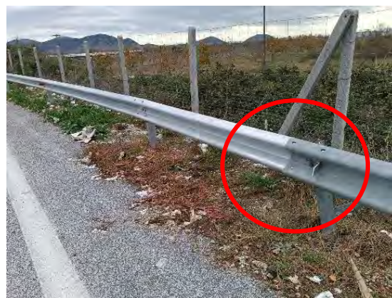
Χ.Θ. : 36+040 : Έλλειψη κοιλίων σύσφιξης & απαιτείται αποκατάσταση
