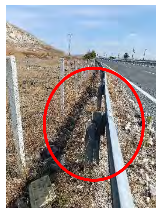
Χ.Θ. : 43+120 : Συναρμογές που δεν πληρούν τις προδιαγραφές & απαιτείται αποκατάσταση, καθώς επίσης διαμόρφωση του gutter και του ρείθρου
