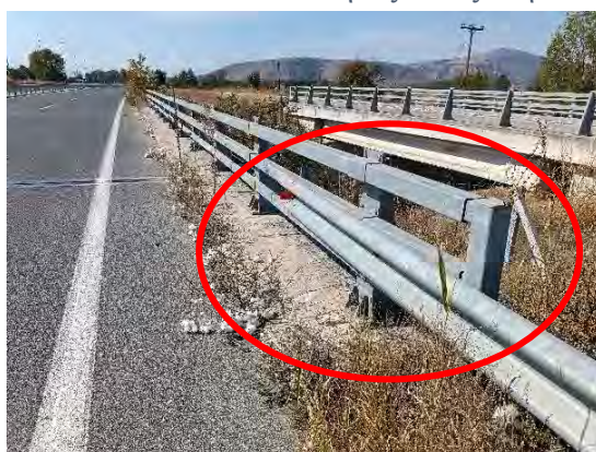
Χ.Θ. : 40+260 : Συναρμογές που δεν πληρούν τις προδιαγραφές & απαιτείται αποκατάσταση
