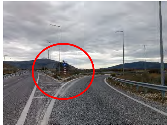
Χ.Θ. : 34+110 : Απαιτείται η τοποθέτηση Σ.Α.Ε.Π. & ευανάγνωστη σήμανση
