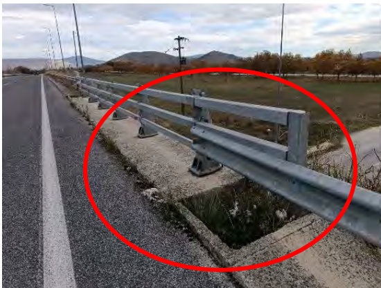
Χ.Θ. : 41+860 : Συναρμογές που δεν πληρούν τις προδιαγραφές & απαιτείται αποκατάσταση
