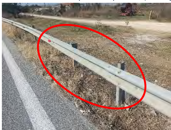
Χ.Θ. : 53+800 : Έλλειψη κοιλίων σύσφιξης & απαιτείται αφαίρεση παλαιών ορθοστατών
