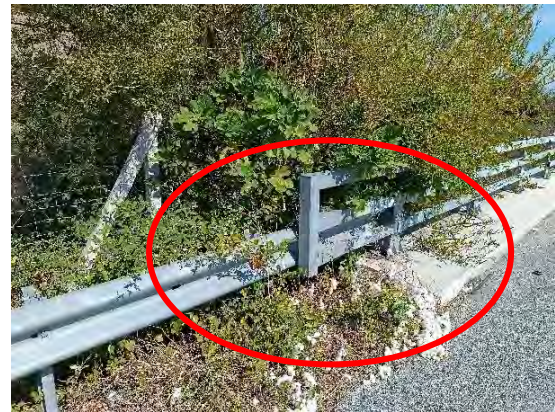
Χ.Θ. : 43+820 : Συναρμογές που δεν πληρούν τις προδιαγραφές & απαιτείται αποκατάσταση
