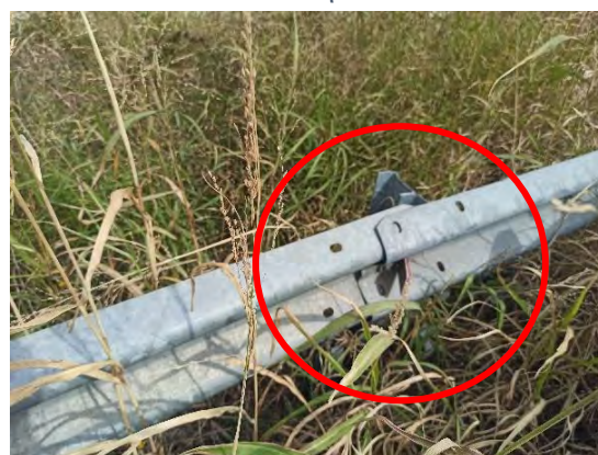
Χ.Θ. : 53+010 : Συναρμογή μη σύμφωνη με τις προδιαγραφές & απαιτείται αποκατάσταση
