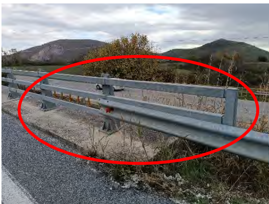
Χ.Θ. : 40+350 : Συναρμογές που δεν πληρούν τις προδιαγραφές & απαιτείται αποκατάσταση
