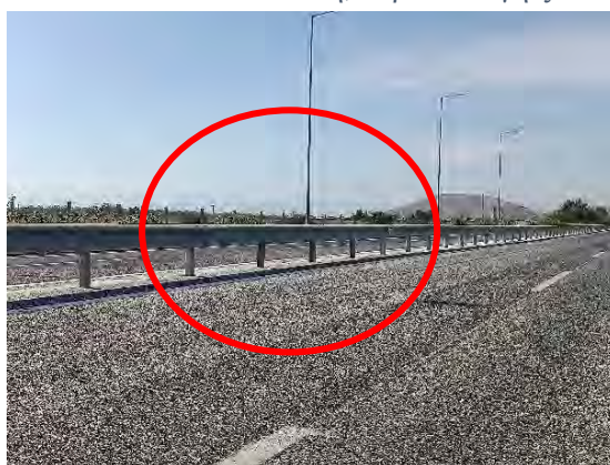
Χ.Θ. : 34+610 : Αντίθετη φορά ορθοστατών & απαιτείται αποκατάσταση
