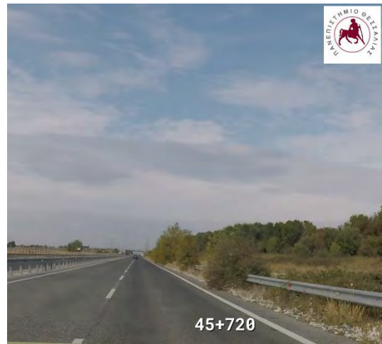
Εικόνες : Υφιστάμενη κατάσταση ερεισμάτων, λόγω βλάστησης – κατεύθυνση προς Τρίκαλα (Πηγή : Ίδια επεξεργασία)
