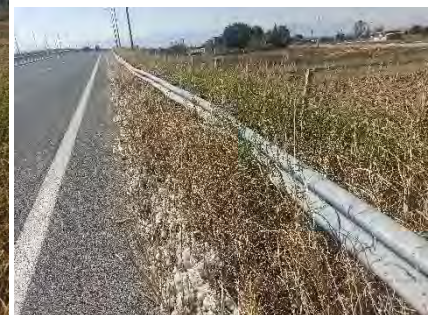
Χ.Θ. : 50+050 : Φθορά σε στηθαίο ασφαλείας & απαιτείται αποκατάσταση
