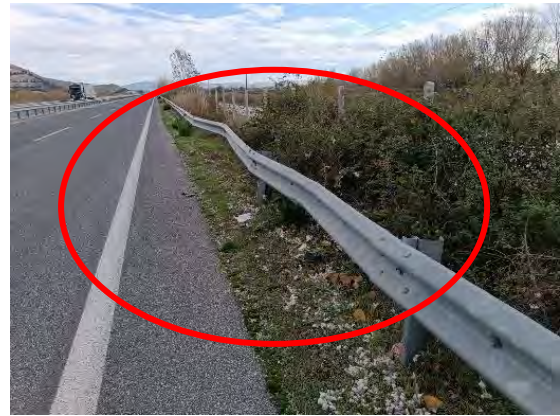
Χ.Θ. : 45+410 : Φθορά σε στηθαίο ασφαλείας & απαιτείται αποκατάσταση
