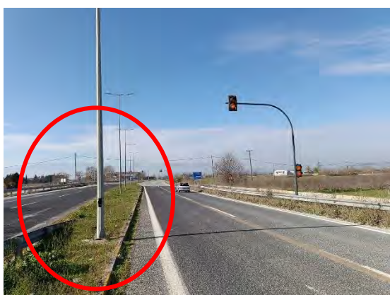
Εικόνες : Επέκταση της ασφάλισης με τον κατάλληλο τύπο στηθαίου ασφαλείας και με τη διαμόρφωση απολήξεων, σύμφωνα με τις προδιαγραφές, στον Ι/Κ Μεγαλοχωρίου (Πηγή : Ιδία επεξεργασία)
