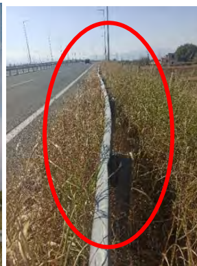
Χ.Θ. : 50+050 : Φθορά σε στηθαίο ασφαλείας & απαιτείται αποκατάσταση
