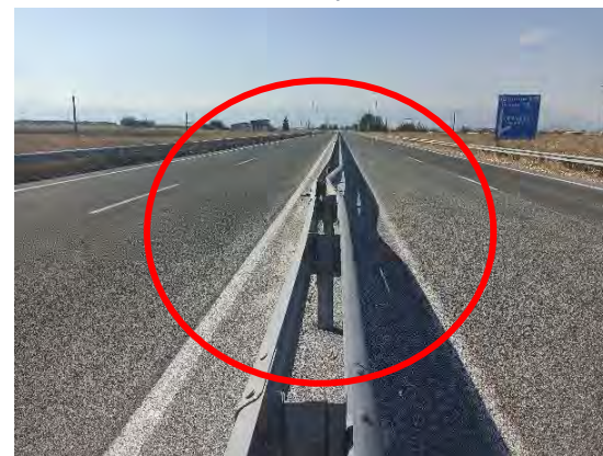
Χ.Θ. : 49+280 : Φθορά σε στηθαίο ασφαλείας & απαιτείται αποκατάσταση
