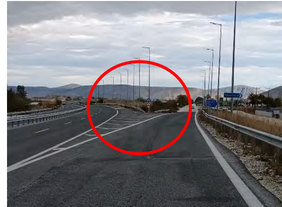
Χ.Θ. : 42+680 : Απαιτείται η τοποθέτηση Σ.Α.Ε.Π. & ευανάγνωστη σήμανση
