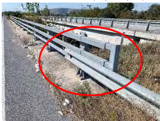
Χ.Θ. : 40+060 : Συναρμογές που δεν πληρούν τις προδιαγραφές & απαιτείται αποκατάσταση
