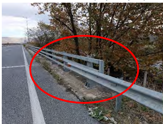
Χ.Θ. : 40+140 : Συναρμογές που δεν πληρούν τις προδιαγραφές & απαιτείται αποκατάσταση
