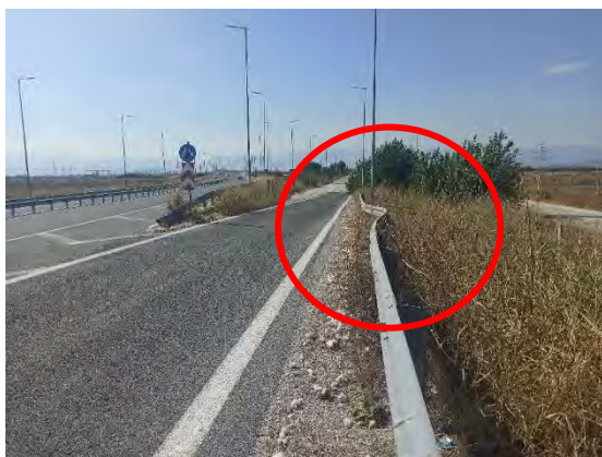
Εικόνες : Φθορά σε στηθαίο ασφαλείας & απαιτείται αποκατάσταση (αριστερά) και επέκταση της ασφάλισης με τη διαμόρφωση απολήξεων, σύμφωνα με τις προδιαγραφές (δεξιά), στον κλάδο εξόδου του Α/Κ Ταξιαρχών, κατεύθυνση προς Τρίκαλα (Πηγή : Ιδία επεξεργασία)
