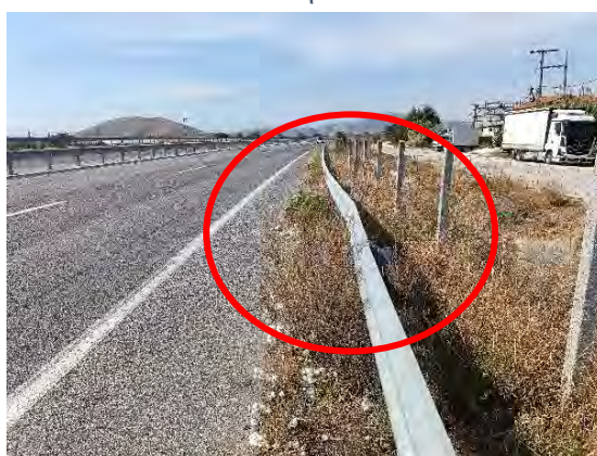
Χ.Θ. : 35+610 : Φθορά σε στηθαίο ασφαλείας & απαιτείται αποκατάσταση
