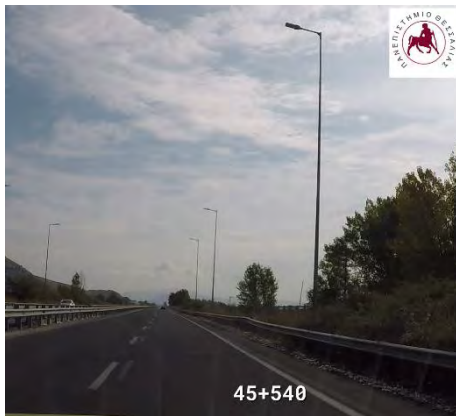
Χ.Θ. : 45+540 : Παρατηρείται ανισοσταθμία των δύο κλάδων, στο ύψος της γέφυρας
