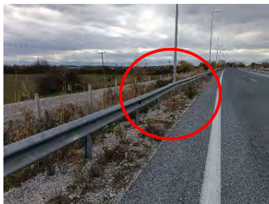
Χ.Θ. : 40+180 : Φθορά σε στηθαίο ασφαλείας & απαιτείται αποκατάσταση
