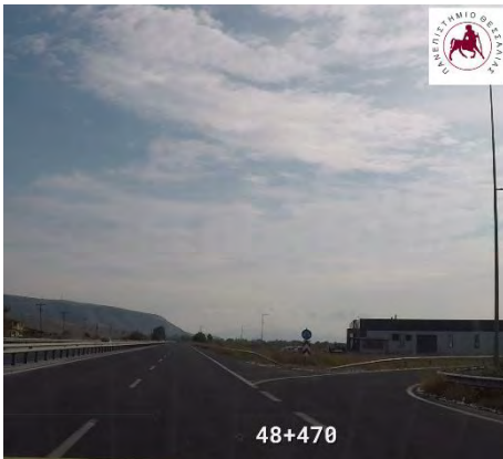
Χ.Θ. : 48+470 : Απαιτείται η τοποθέτηση Σ.Α.Ε.Π. & ευανάγνωστη σήμανση
