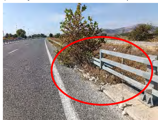
Χ.Θ. : 40+260 : Συναρμογές που δεν πληρούν τις προδιαγραφές & απαιτείται αποκατάσταση
