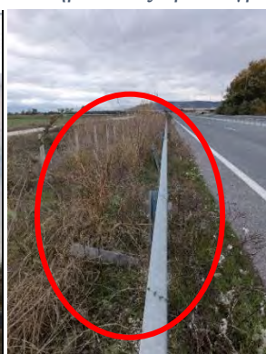
Χ.Θ. : 38+520 : Έλλειψη κοιλίων, απαιτείται αποκατάσταση & αφαίρεση παλαιών ορθοστατών
