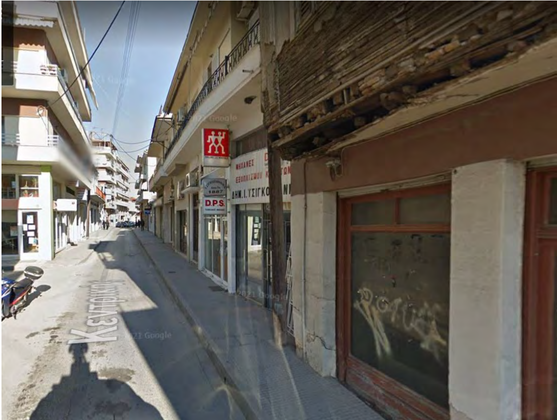
Εικόνα 5.1: Οδός Κεντρικής, που είναι έντονο το στοιχείο της. Πηγή: Google Maps.
