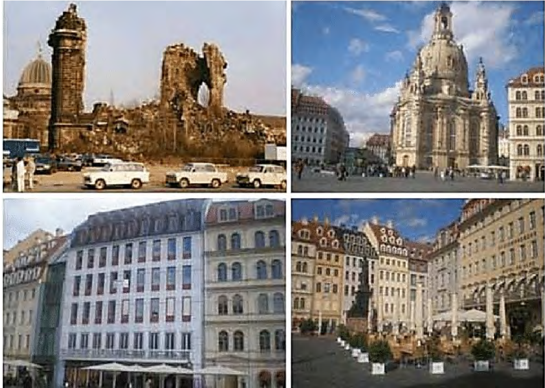
Εικόνα 2.1 Δρέσδη: Η εκκλησία της Παναγίας σε κατάσταση κατάρρευσης πάνω αριστερά, ενώ πάνω δεξιά η ίδια εκκλησία ανακατασκευάστηκε, κάτω εικόνες εικονίζεται η αναπλασμένη πλατεία. Πηγή: https://lehmstedt.de ).
