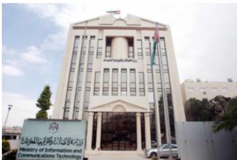
Εικόνα 54: Υπουργείο Επικοινωνίας και Πληροφόρησης Τεχνολογίας
