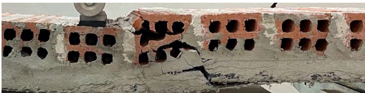
Σχήμα 4.21: Εικόνα αστοχίας του δοκιμίου "OOP_WALL_CEM-G-111".
