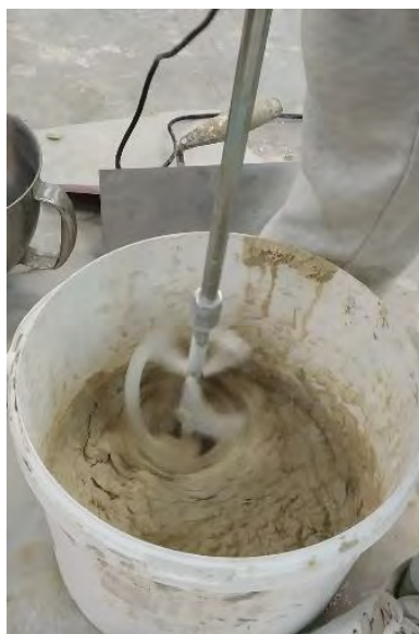
Σχήμα 3.3: Ανάμειξη κονιάματος γεωπολυμερικής σύστασης.
