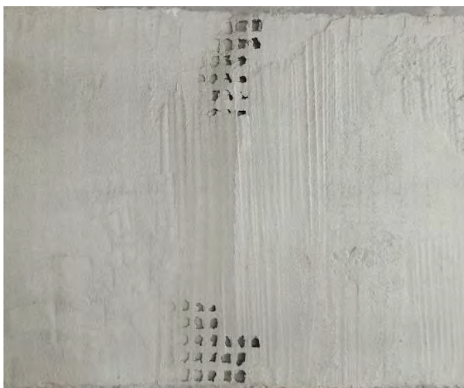
Σχήμα 4.22: Εικόνα αστοχίας του δοκιμίου "OOP_WALL_CEM-G-111".
