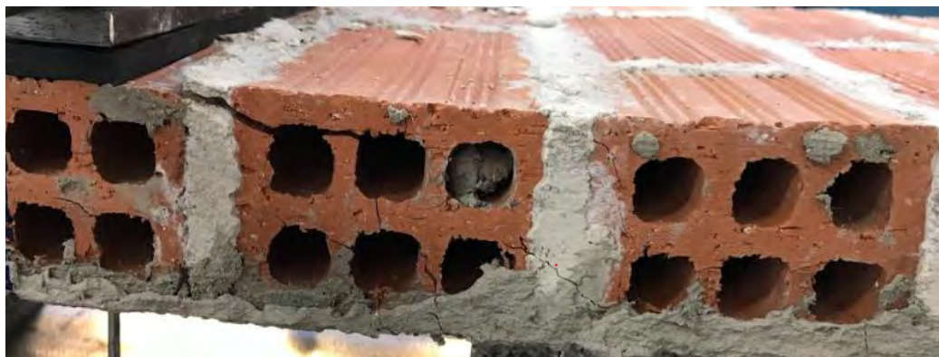
Σχήμα 4.6: Εικόνα αστοχίας του δοκιμίου "OOP_WALL_CEM-B2".
