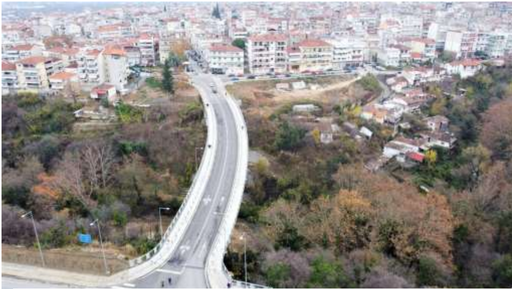
Εικόνα 8 Γέφυρα Κούσιου. Πηγή: Ίδια Επεξεργασία
