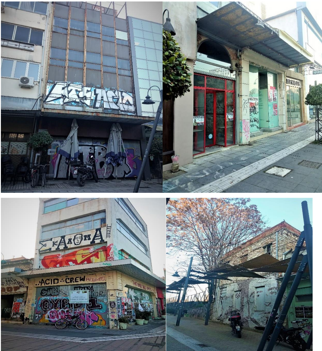
Εικόνες 33-36. Εγκαταλελειμμένο κτιριακό απόθεμα στην οδό Βενιζέλου. Προσωπικό αρχείο (Δεκέμβριος, 2022).
