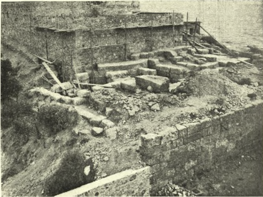
Εἰκ. 3. Μία ἄποψις τῆς ἀνασκαφῆς κατὰ τὴν δυτικὴν πλευρὰν τοῦ οἰκοδομήματος τοῦ Ναυτικοῦ Ὁμίλου τῆς Ἑλλάδος. Διακρίνονται ὁ στρογγύλος πύργος καὶ τὸ περὶ αὐτὸν συγκρότημα ἀναλημμάτων.
