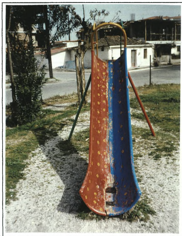
Φωτο 5: Η απουσία της συντήρησης και της επισκευής στην τσουλήθρα.
