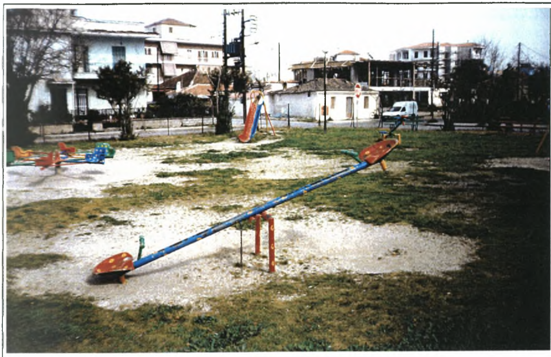
Φωτο 8 : Η απουσία του απορροφητικού υλικού κάτω από την τραμπάλα.
