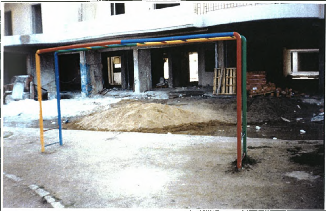
Φωτο 6: Η απουσία του απορροφητικού υλικού και η παρουσία.. των οικοδομικών υλικών δίπλα.
