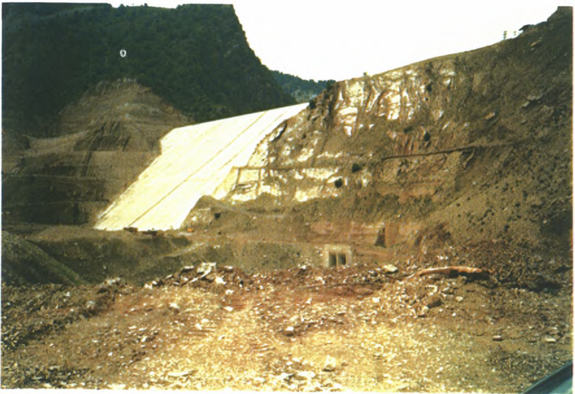
Εικόνα 4. Έργα εκτροπής του Αχελώου (φράγμα στην περιοχή Μεσοχώρας)
