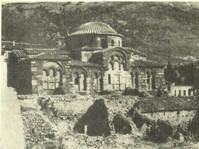
Εἰκ. 5. Ἡ Ν. πλευρὰ τοῦ ναοῦ τοῦ Ὁσ. Λουκά πρὸ τοῦ ἀνοίγματος τῶν παραθύρων.
