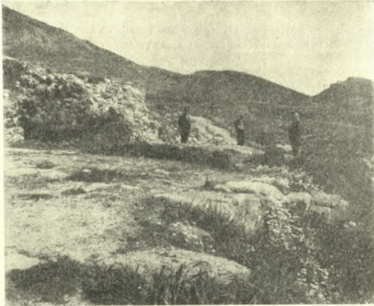
Εἰκ. 1. Ἐπιπέδισ τοῦ μεγάρου τῶν Μυκηναίων ἀπὸ Δ. πρὸ τῶν ἐργασιῶν στερεώσεως καὶ ἀναστηλώσεως.
