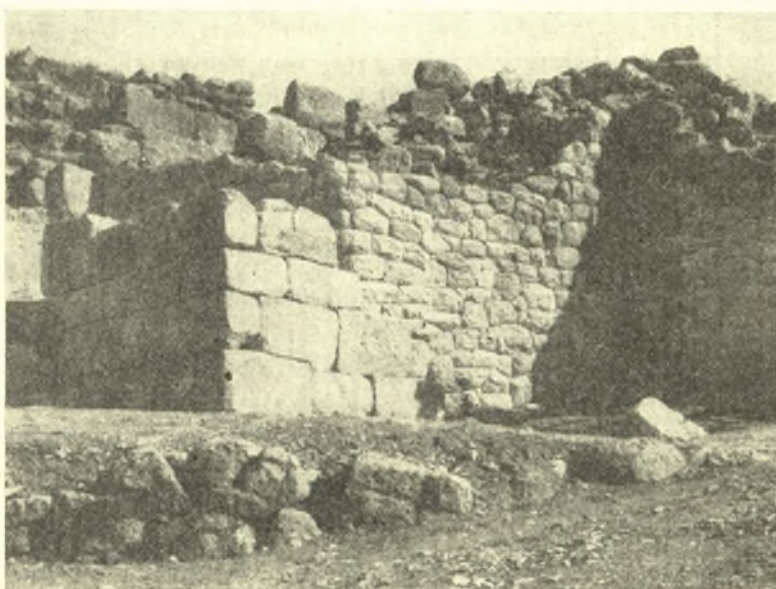
Εἰκ. 4. Τὸ νοτίως τῆς πύλης τῶν λεαινῶν ἀποκαλυφθὲν τμῆμα τοῦ τείχους τῶν Μυκηνῶν καὶ ὁ πρὸ αὐτοῦ ἀναστηλωθεὶς ὀρθογώνιος πύργος.
