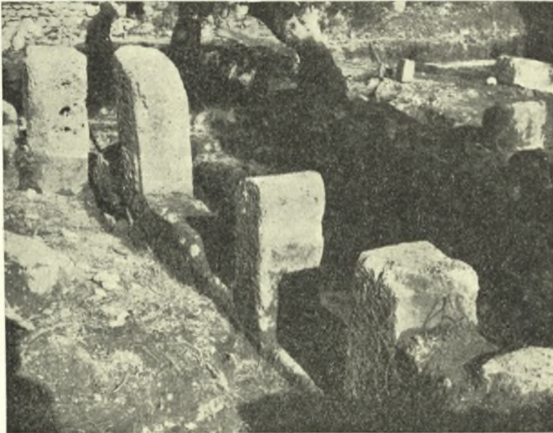
Εἰκ. 3. Σύστημα δομῆς τοῦ χωρίζοντος τὸν κυρίως ναὸν ἀπὸ τοῦ νάρθηκος τοίχου.
