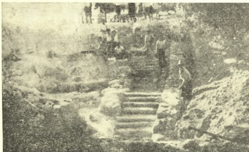
Εἰκ. 18. Ἡ κλιμαξ τῆς μινωικῆς ἐπαύλεως Σητείας ἐξ Ἀνατολῶν κατὰ τὴν διάρκειαν τῆς ἀνασκαφῆς.
