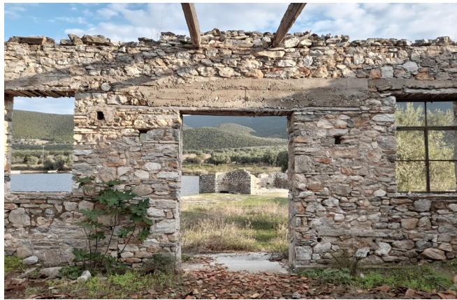
Εικόνα 23. Κτίριο 5 – Μεγάλη αποθήκη
