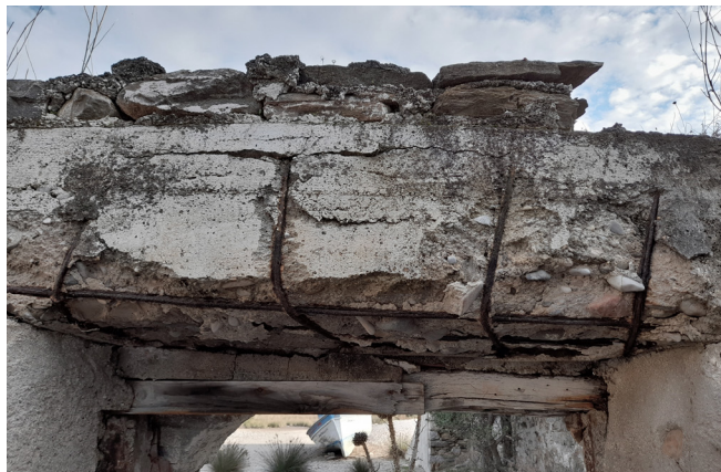
Εικόνα 20. Κτίριο 4 - Βοηθητικός χώρος
