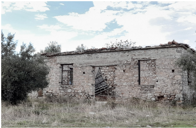
Εικόνα 22. Κτίριο 5 – Μεγάλη αποθήκη
