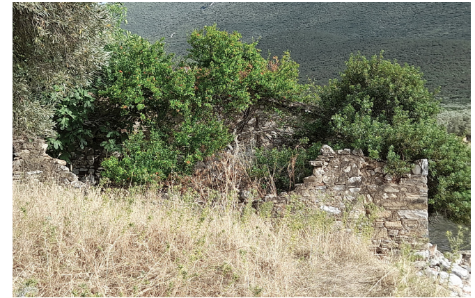
Εικόνα 30. Κτίριο 7 - Βοηθητικός χώρος
