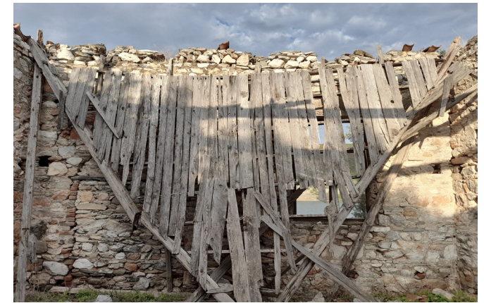
Εικόνα 24. Κτίριο 5 – Μεγάλη αποθήκη
