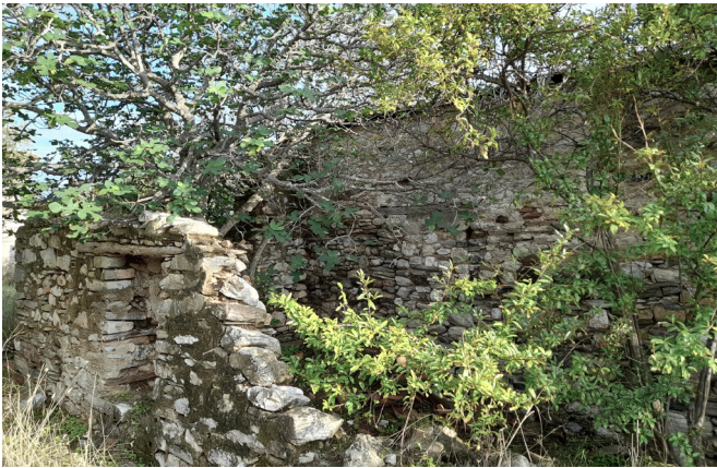
Εικόνα 28. Κτίριο 7 - Βοηθητικός χώρος
