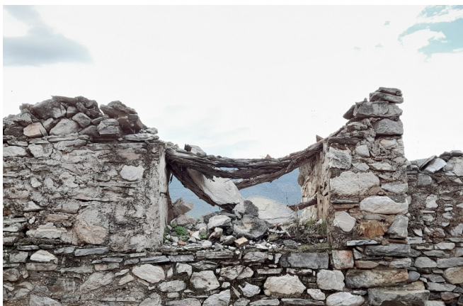
Εικόνα 26. Κτίριο 6 – Χώρος φαγτού
