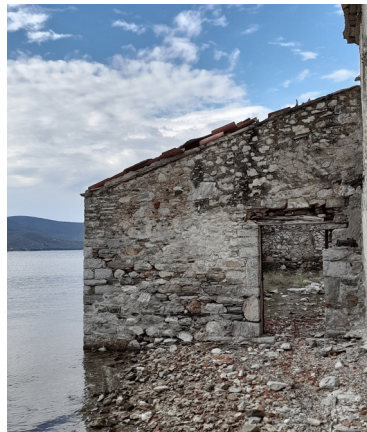
Εικόνα 25. Κτίριο 6 – Χώρος φαγτού
