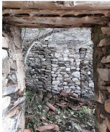
Εικόνα 29. Κτίριο 7 - Βοηθητικός χώρος
