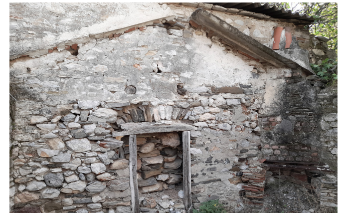
Εικόνα 21. Κτίριο 4 - Βοηθητικός χώρος
