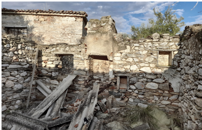
Εικόνα 19. Κτίριο 4 - Βοηθητικός χώρος
