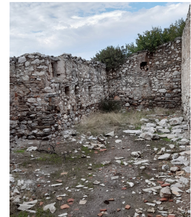
Εικόνα 27. Κτίριο 6 – Χώρος φαγτού
