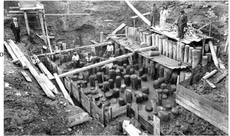
Εικόνα 2.4. Πασσαλοπηξία στην Βενετία
