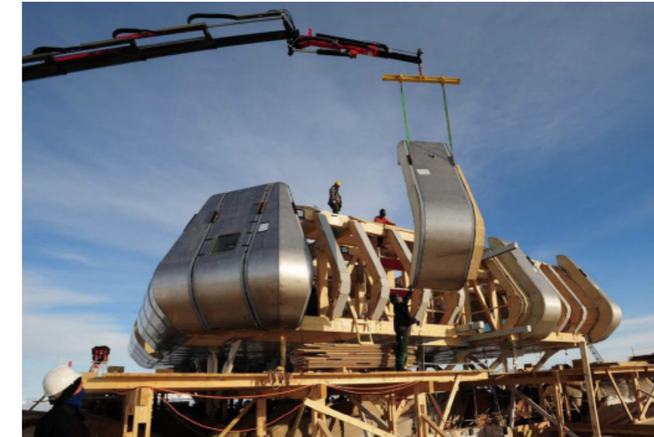
Εικ. 12 Στάδιο εγκατάστασης πάνελ στη δομή. Ρωγμή παγετών Πηγή: https://www.coolantarctica.com/Bases/modern_antarctic_bases4.php [Πρόσβαση : 07-08-2022]
