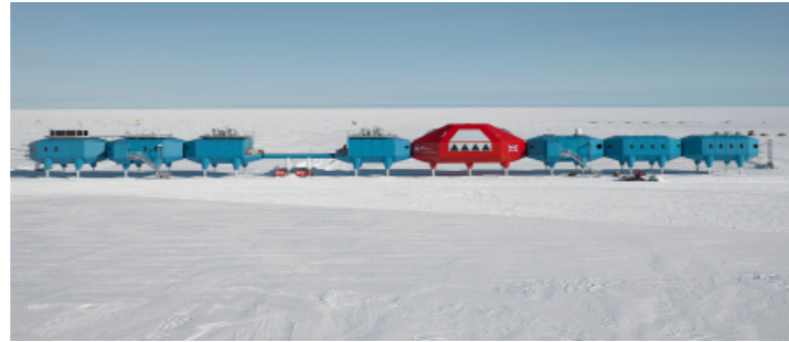
Εικ. 22 Γενική άποψη μονάδων Πηγή: https://www.architectural-record.com/gdpr-policy?url=https%3A%2F%2Fwww.architectural-record.com%2Farticles%2F2789-halley-vi-antarctic-research-station-by-hugh-broughton-architects [Πρόσβαση : 25-07-2022]
