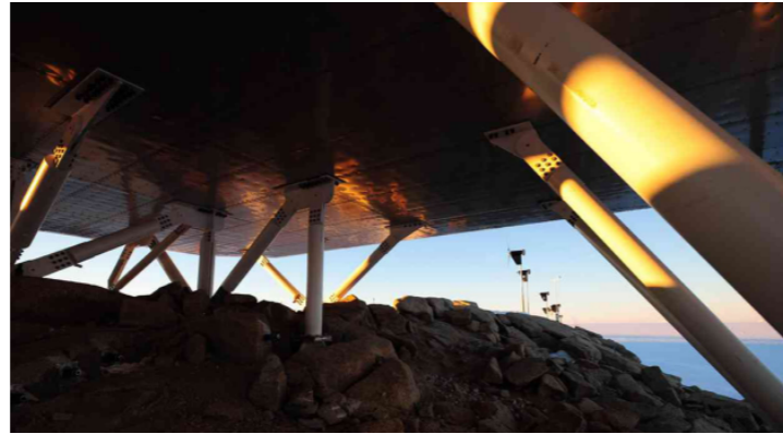
Εικ. 10 Μεταλλικά υποστυλώματα Princess Elisabeth Πηγή: https://www.coolantarctica.com/Bases/modern_antarctic_bases4.php [Πρόσβαση : 03-08-2022]
