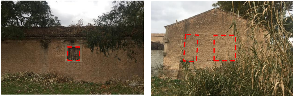
Εικόνα 44: Κτ. 6 – Αρχικά ανοίγματα βόρειας και ανατολικής όψης
