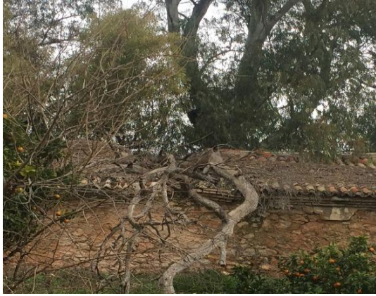
Εικόνα 36: Πτώση, επί της στέγης Κτ.6, κλαδιών μεγάλου μεγέθους και βάρους
