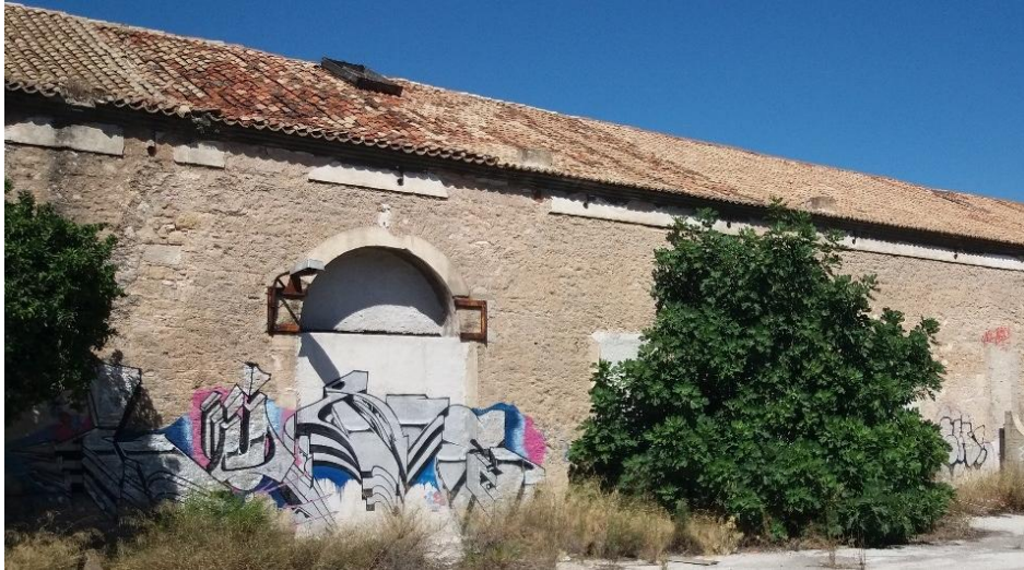
Εικόνα 28: Δίρριχτη στέγη Κτ. 5 με επικάλυψη βυζ. κεραμιδιών
