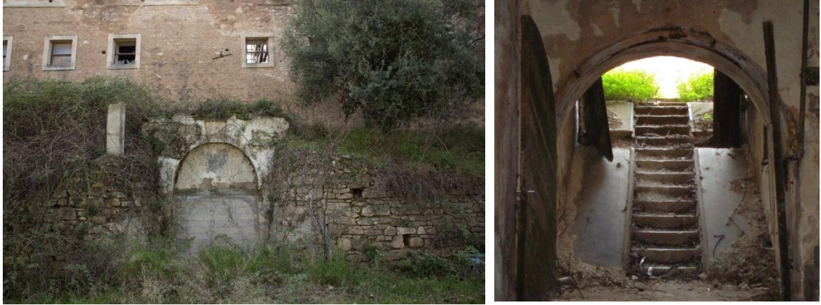
Εικόνα 25: Κτ. 5 - Είσοδοι προς υπόγειο και κλίμακα
