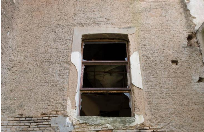
Εικόνα 46: Βλάβες στις κορνίζες των παραθύρων
