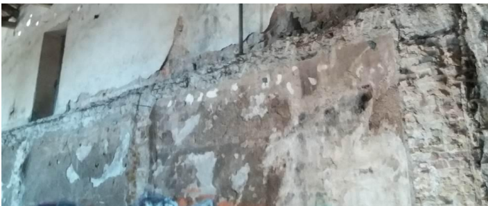
Εικόνα 38: Κτ.1 – Προσθετο τοιχείο στο εσωτερικό
