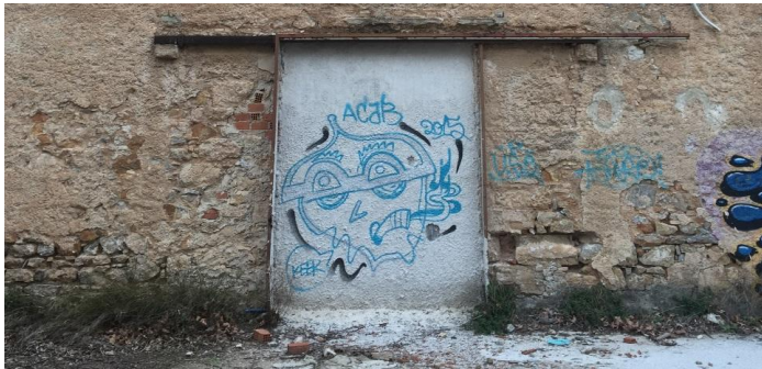
Εικόνα 257: Κτ.1 – Χτισμένη θύρα
