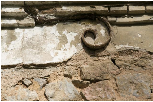
Εικόνα 30: Μεταλλικά στοιχεία όψεων
