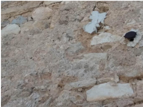
Εικόνα 26: Φέρουσα τοιχοποιία από λιθοδομή
