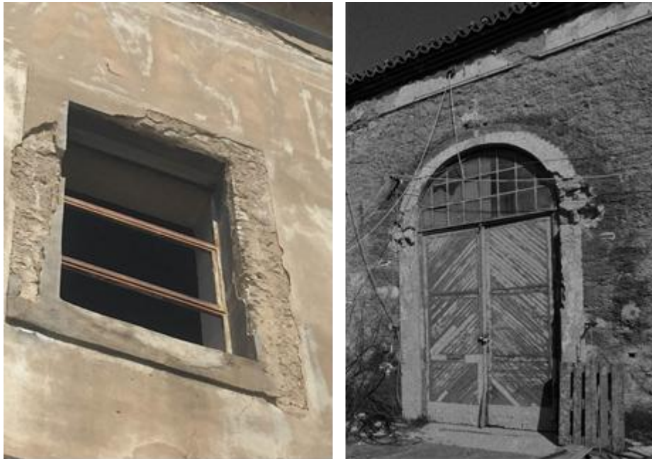
Εικόνα 29: Υφιστάμενα μεταλλικά παράθυρα και ξύλινη θύρα από παλαιότερη φωτογραφία
