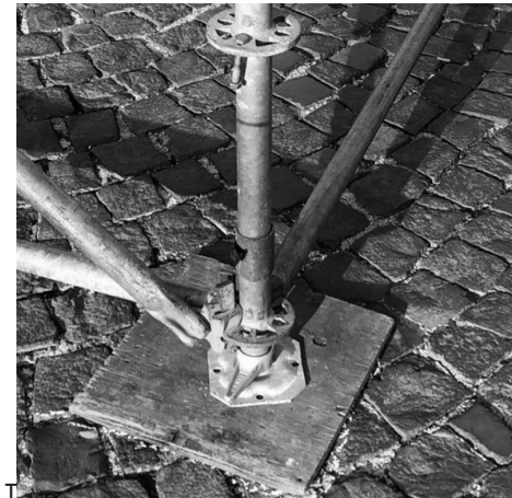
Η βάση του ικρίωματος πατάει πάνω σε μια επιφάνεια ξύλου η οποία προστίθεται για στερέωση και κάποιες φορές προσαρμόζοντας το πάχος αυτής της επιφάνειας εξισορροπεί την ανομοιομορφία του εδάφους. Φαίνεται να αποφεύγεται το βίδωμα της βάσεις σε οποιαδήποτε επιφάνεια ή το έδαφος καθώς δεν είναι απαραίτητο, παρά τις οπές που υπάρχουν από την παραγωγή.
