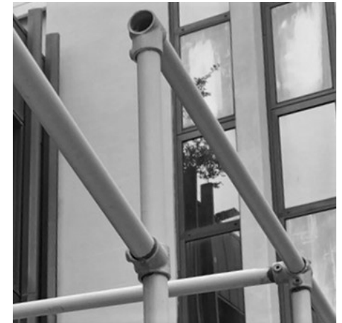
Όταν γίνεται επιστροφή σε αυτού του τύπου το ικρίωμα, χωρίς τις ροζέτες ο τρόπος σύνδεσης είναι αυτός με περιστροφή στα αντιστοιχα παξιμάδια.
