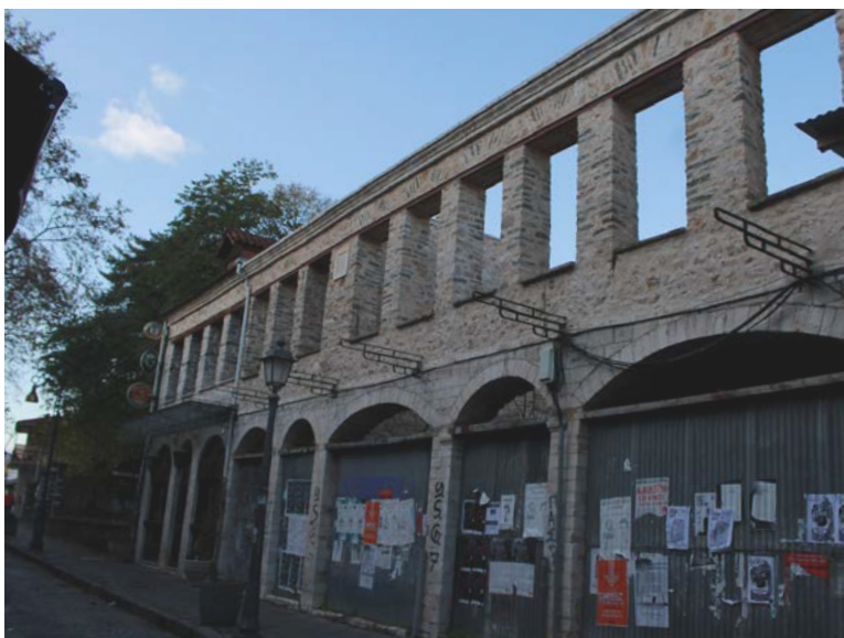
Εικ. 64 Παρούσα κατάσταση όψης κτηρίου στην οδό Ανεξατηρσίας, 2022
