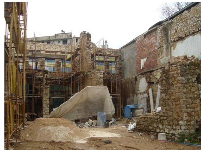
Εικ. 63 Εργασίες συντήρησης, αρχείο Υπηρεσίας Νεωτέρων Μνημείων και Τεχνικών Έργων Ηπείρου
