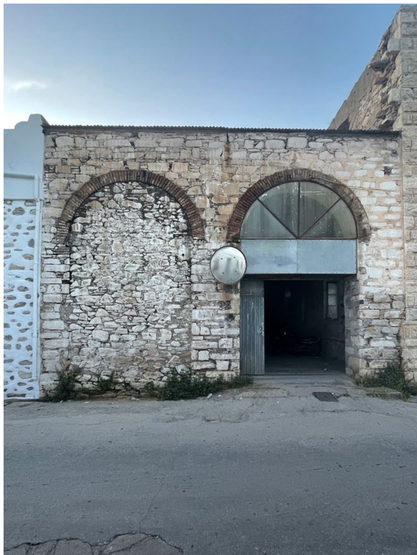
Πρόσοψη κτιρίου αποθηκών
