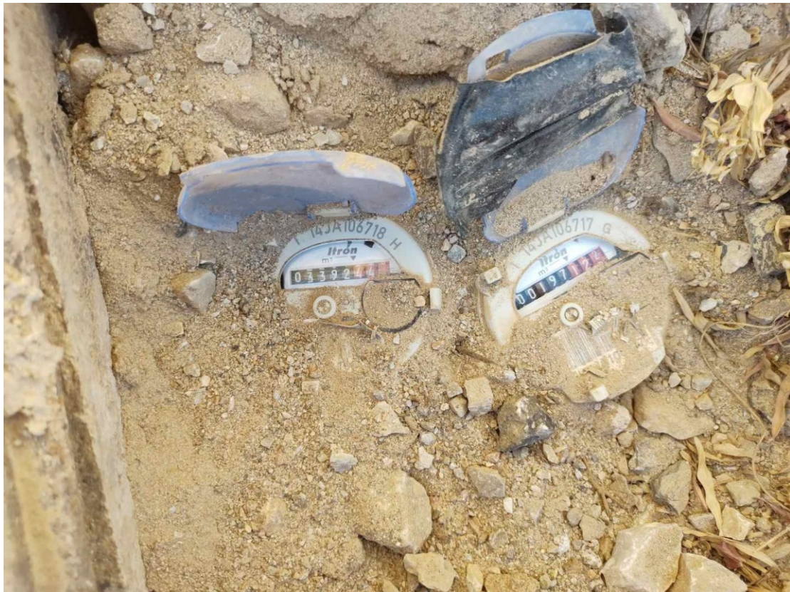
Εικόνα 16 Υδρομετρητές εκτός φρεατίου, εκτός οικισμού, στην περιοχή των Καταπόλων (Φωτογραφία Εμμανούλη Πράσιнос)
