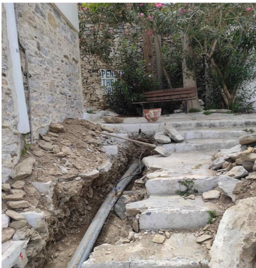
Εικόνα 51 Αντικατάσταση αγωγού στη θέση Βροντάδο εντός του οικισμού των Καταπόλων (Φωτογραφία: Παπαγιάννης Άγγελος)
