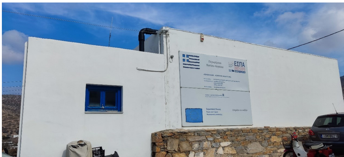
Εικόνα 17 Δεξαμενή Ραχιδίου (Φωτογραφία Μηνάς Γαβαλάς)
