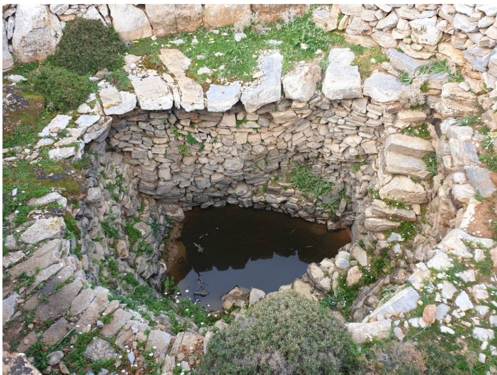
Εικόνα 2 Πετρόχτιστη ανοιχτή δεξαμενή στη θέση Τερλάκι Αμοργού (Φωτογραφία: Σμιδαλάς Εμμανουήλ)
