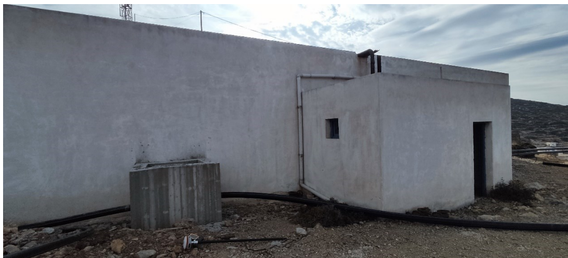
Εικόνα 21 Η νέα δεξαμενή της Αρκεσίνης (Φωτογραφία Γαβαλάς Μηνάς)
