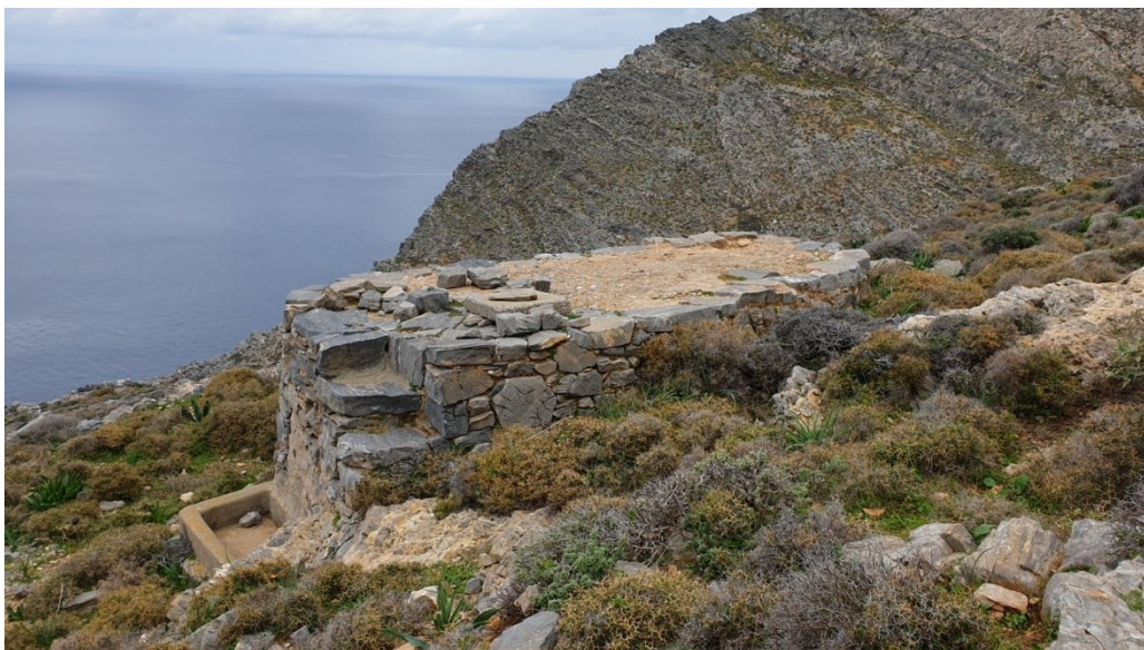
Εικόνα 3 Πετρόχτιστη κλειστή δεξαμενή στη θέση Θεολόγος Αμοργού (Φωτογραφία: Σμιδαλάς Εμμανουήλ)
