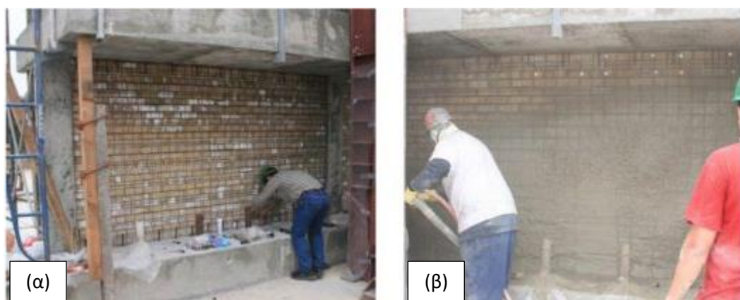
Σχήμα 2.3: (α) Τοποθέτηση πλέγματος χαλύβδινου οπλισμού και βλήτρων χάλυβα στο φάτνωμα ΟΣ (β) εφαρμογή εκτοξευμένου κονιάματος, οπλισμένο με πλαστικές ίνες (Koutromanos et al., 2013)
