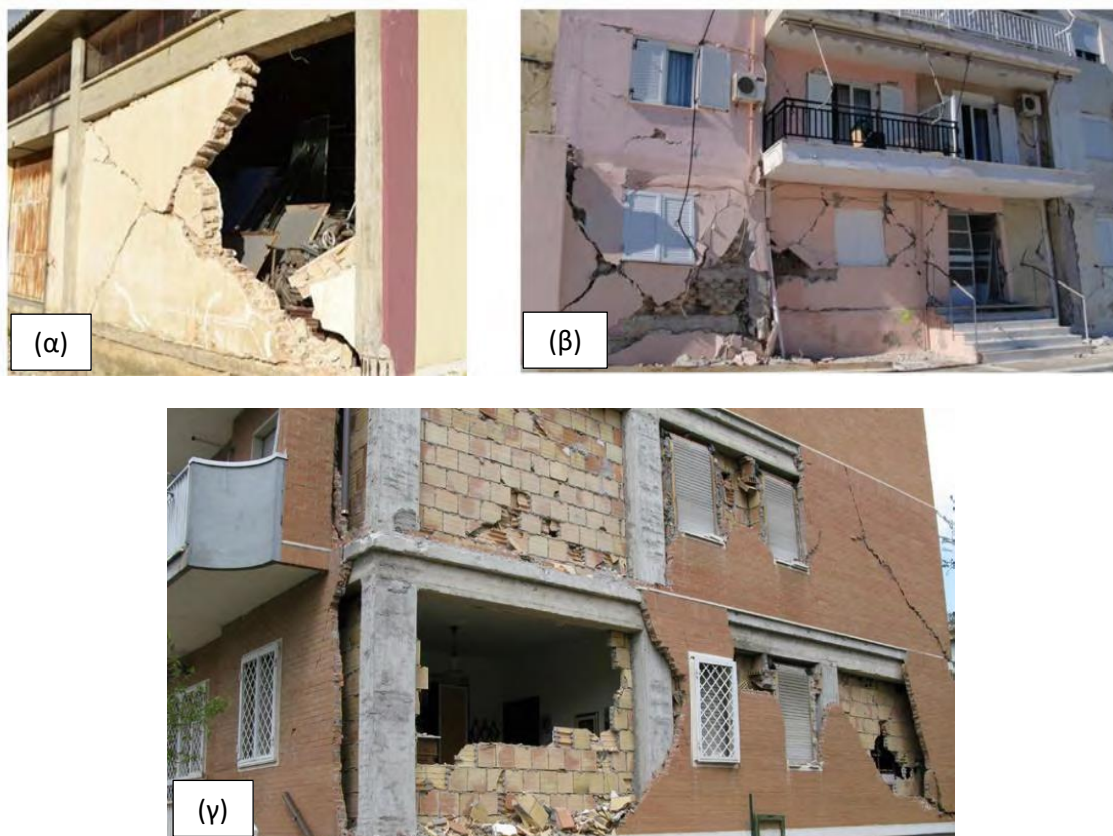
Σχήμα 1.1: Εικόνες από αστοχίες τοιχοπληρώσεων σε πλαισιακές κατασκευές ΟΣ κατά τα σεισμικά γεγονότα: (α), (β) Κεφαλονιά-Ελλάδα 2014, Ms 5.9., (Κούτας, 2015) (γ) L' Aquila-Ιταλία 2009, Ms 6.3 (Κούτας, 2015)
