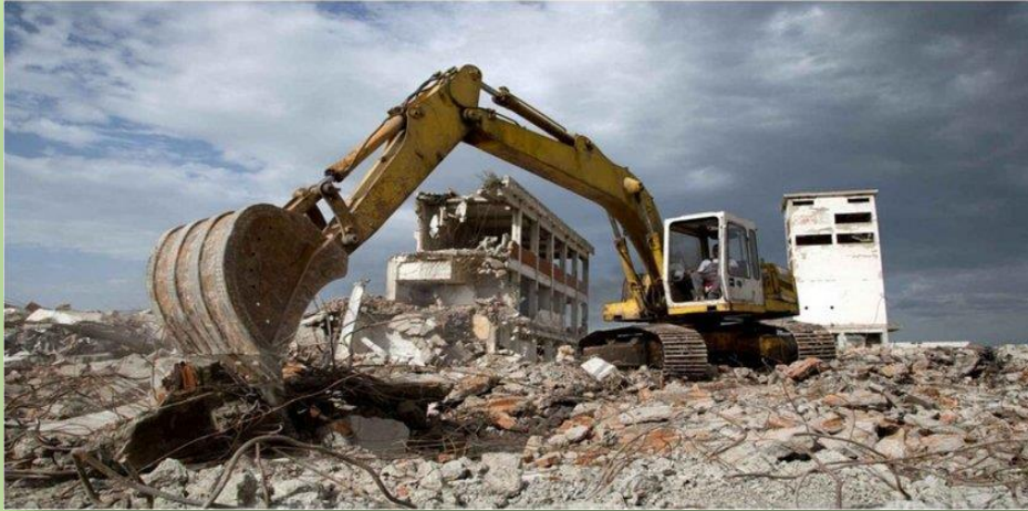
ΕΙΚΟΝΑ 13: ΑΠΟΒΛΗΤΑ ΕΚΣΚΑΦΩΝ, ΚΑΤΑΣΚΕΥΩΝ ΚΑΙ ΚΑΤΕΔΑΦΙΣΕΩΝ Πηγή: (Magar, 2020)
