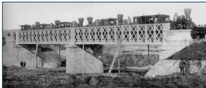
Εικόνα 42 Σιδηροδρομική γέφυρα κατά τη λειτουργία της. Πηγή : Δ.Μιχαηλίδης, 1884
