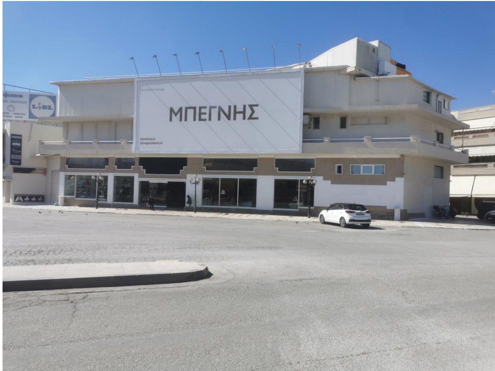
Εικόνα 3. Κύρια κτιριακή εγκατάσταση της «Μπεγνής Catering»
