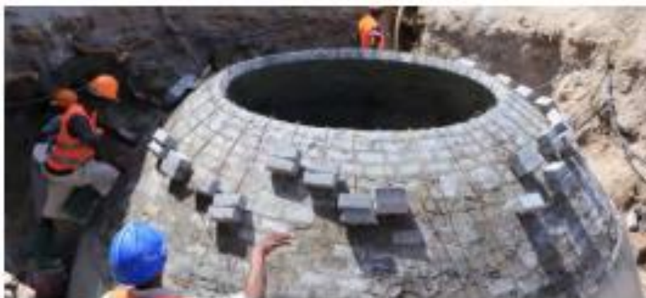
Εικόνα 9 Κατασκευή ασφαλούς απόρριψης φαγητών στην οποία δημιουργείται βιοκαύσιμο για χρήση των εγκαταστάσεων του Νοσοκομείου Mwananyamaka (Tanzania) ( https://noharm-global.org/sites/default/files/documents-files/6465/Global%20Programs%20annual%20report%202019.pdf )
