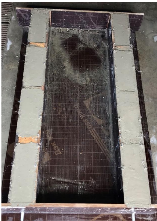
Σχήμα 4.6 Τα καλούπια μετά το τέλος της σκυροδέτησης.
