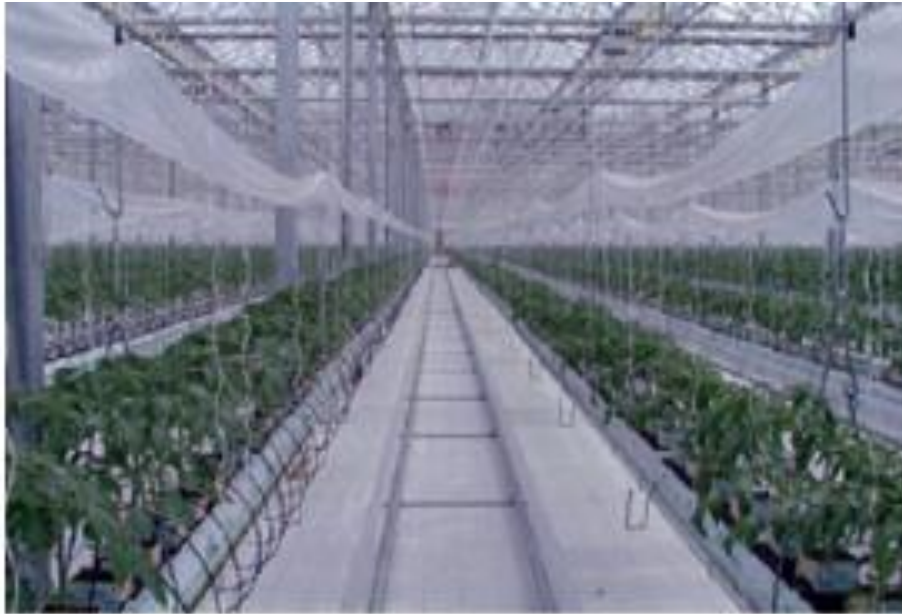
Εικόνα 3.11 Σωλήνες σε ράγες εντός του θερμοκηπίου (Kittas et al., 2013)
