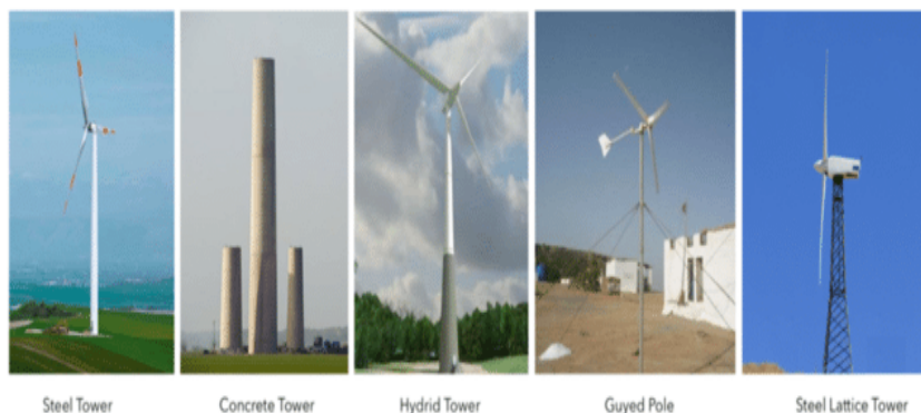
Εικόνα 2.2. Τύποι πύργων ανεμογεννητριών. Διαθέσιμο στο: https://www.researchgate.net/figure/Types-of-wind-turbine-tower-202122_fig6_329680977
