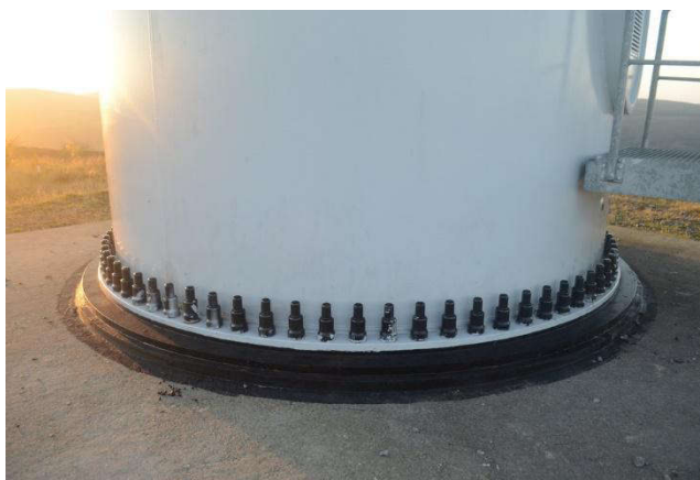
Εικόνα 2.4 Βίδες συγκράτησης για μια ανεμογεννήτρια
