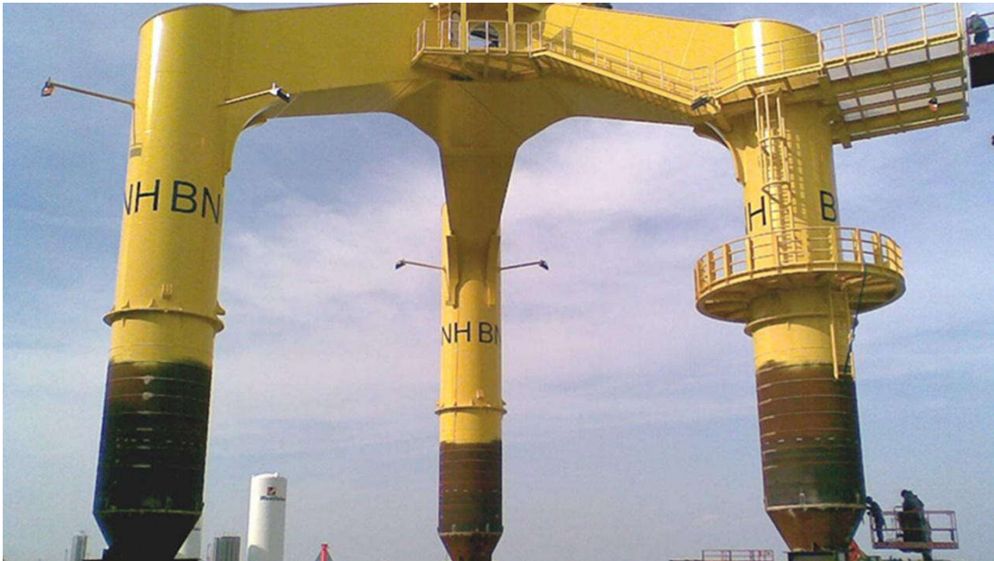
Εικόνα 2.10 Τρίποδες για θεμελίωση ανεμογεννητριών. Διατίθεται στη διεύθυνση https://maritek.com.ua/portfolio-item/foundations-of-tripiles-for-the-bard-offshore/
