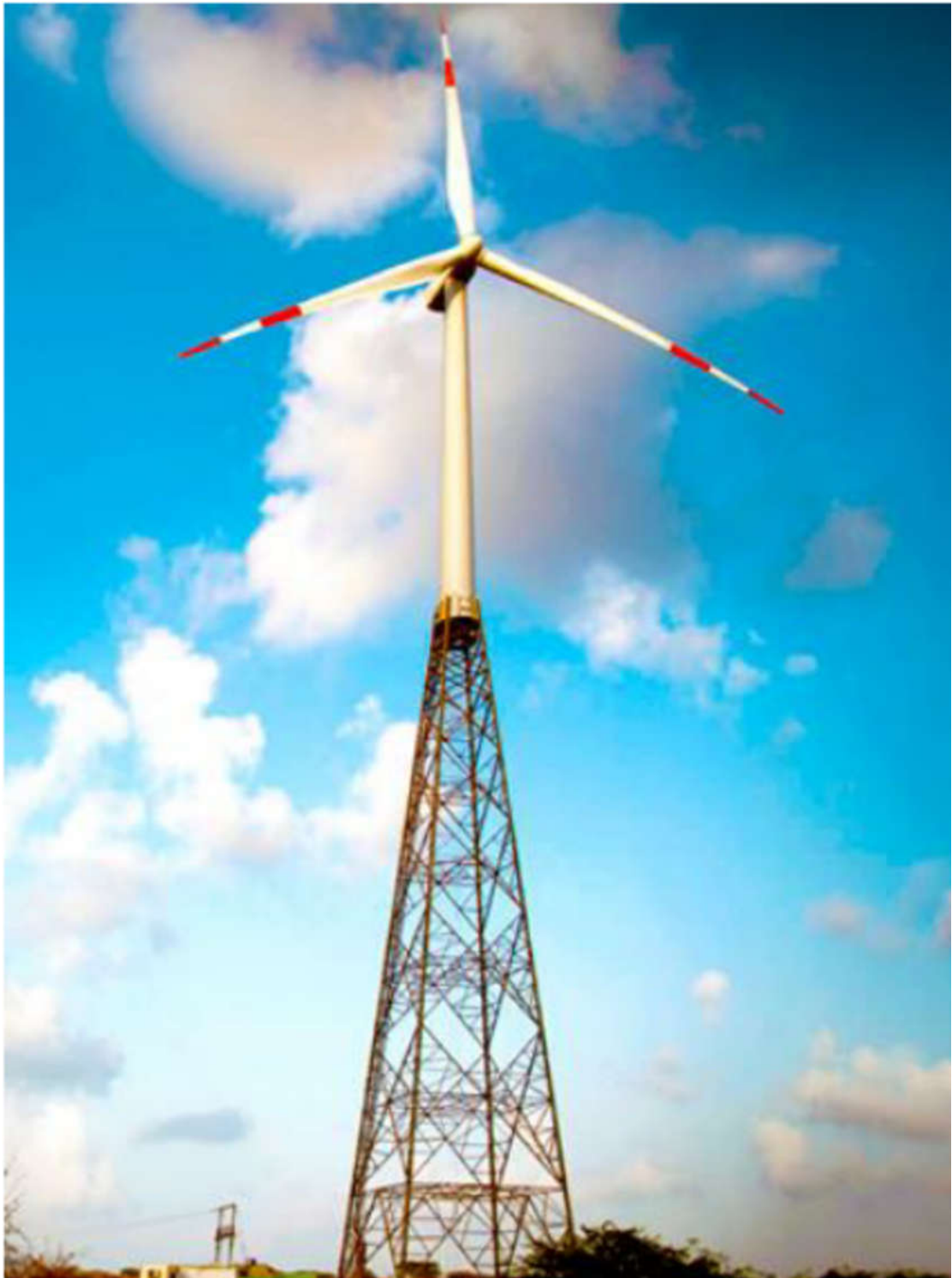
Εικόνα 2.6 Ανεμογεννήτρια υβριδικού πύργου. Διαθέσιμο στη διεύθυνση https://www.researchgate.net/figure/Hybrid-lattice-tubular-tower_fig5_292610311
