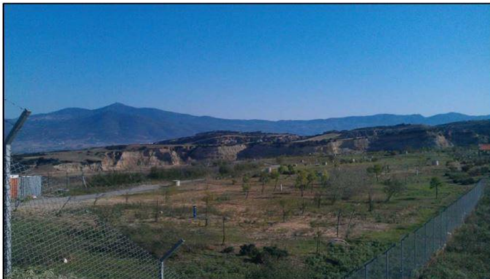
Εικόνα 22: Πηγάδια άντλησης βιοαερίου της Β' φάσης ανάπλασης του ΧΥΤΑ Ταγαράδων
