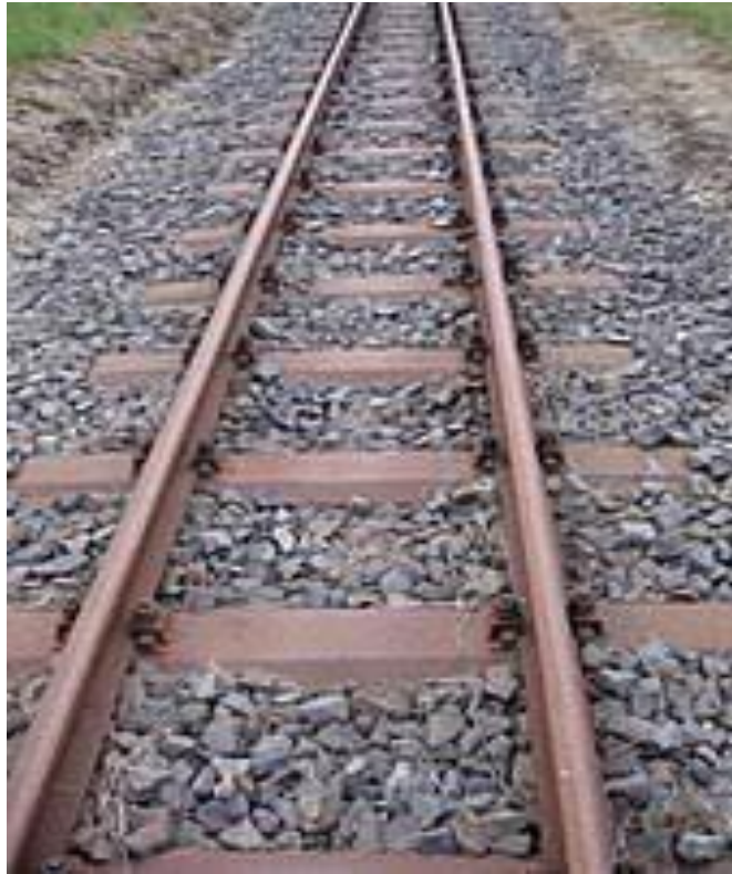
Εικόνα 14- Έδραση με έρμα (Πηγή: el.wikipedia.org)
