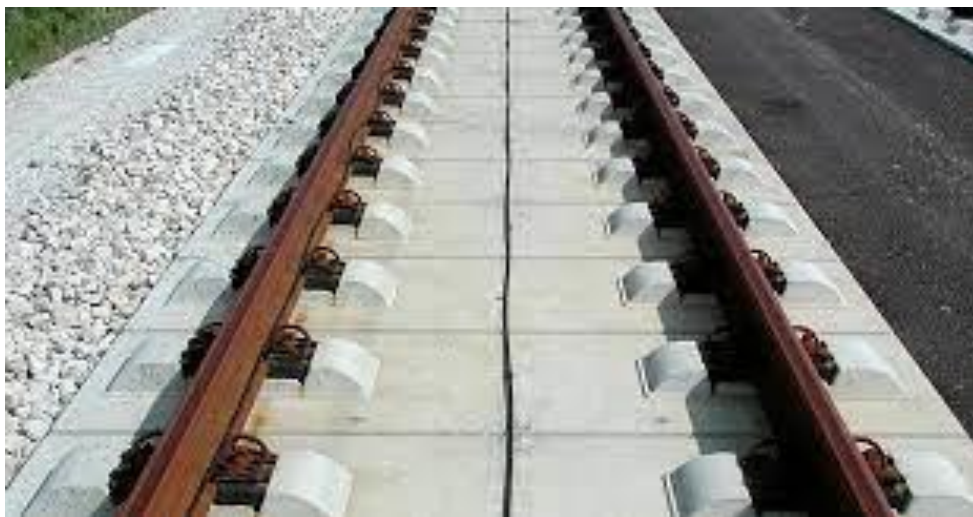
Εικόνα 15- Σταθερή επιδομή (Πηγή: mixanikosose.blogspot.com )
