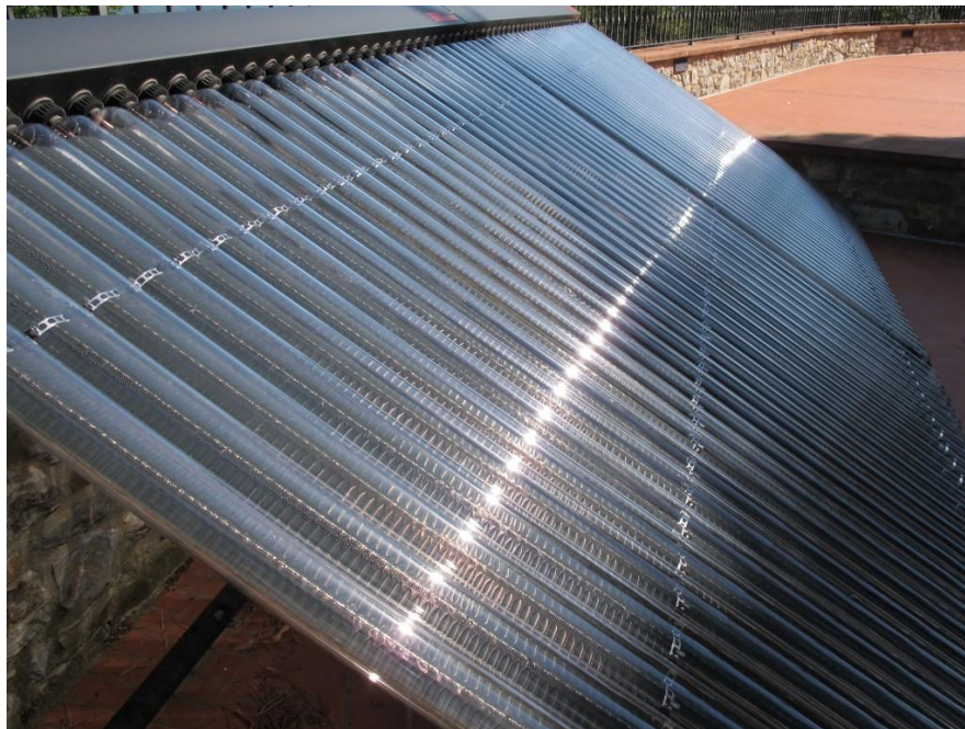
Εικόνα 2.2: Ηλιακοί συλλέκτες κενού (ETC). [19]
