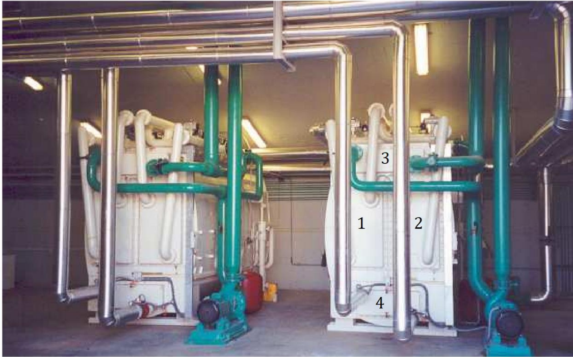
Εικόνα 2.7: Ψύκτες προσρόφησης του ηλιακού σταθμού "ΦΩΤΟΝΙΟ": 1: ΘΡ1, 2: ΘΡ2, 3: Συμπυκνωτής, 4: Ατμοποιητής. [14]
