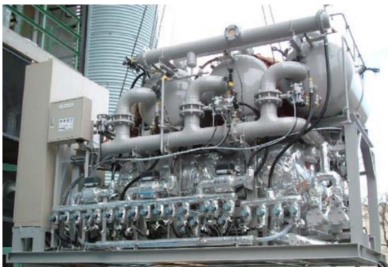
Εικόνα 3.1: Ψύκτης τριών βαθμίδων – έξι θαλάμων ρόφησης. [43]
