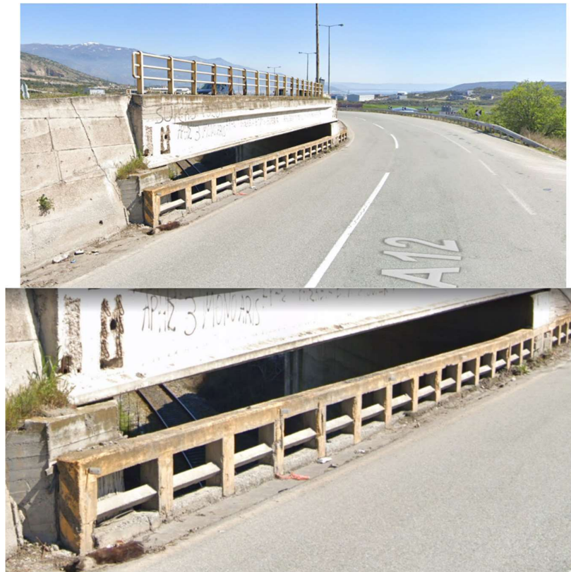
Σχήμα 3.3: Εικόνες της γέφυρας στην Χ.Θ. 3+457
