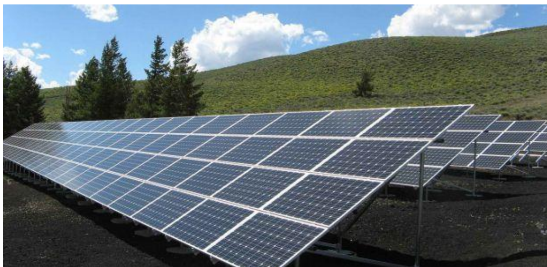
Εικόνα 3. Εγκατάσταση φωτοβολταϊκών. Πηγή: https://dasarxeio.com/2021/12/10/105862/
