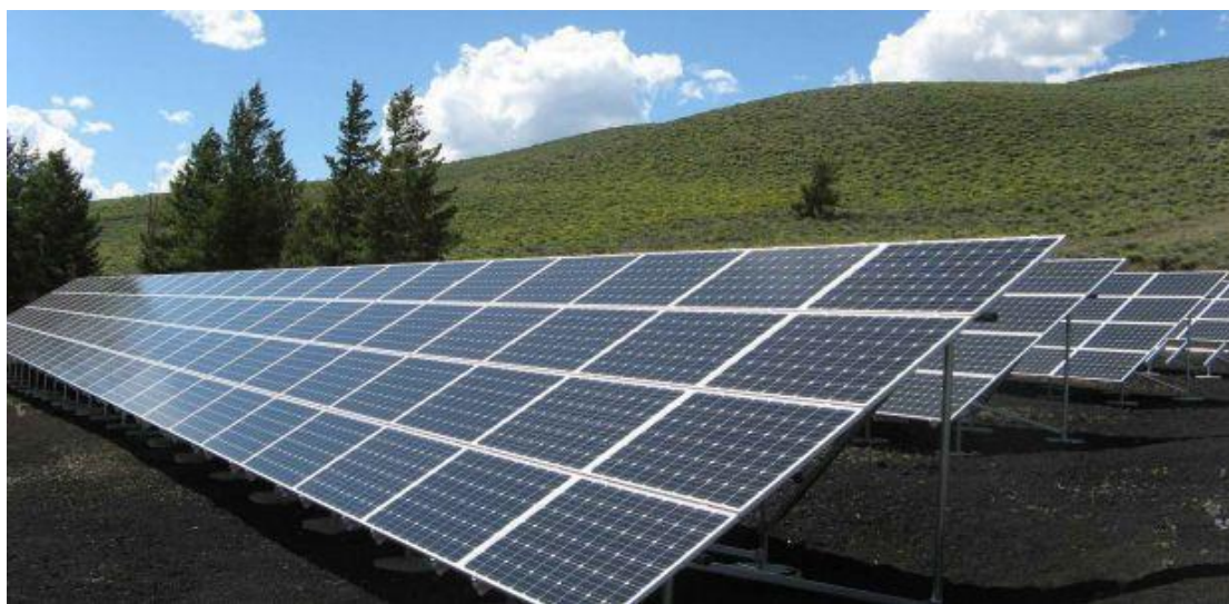
Εικόνα 3. Εγκατάσταση φωτοβολταϊκών. Πηγή: https://dasarxeio.com/2021/12/10/105862/
