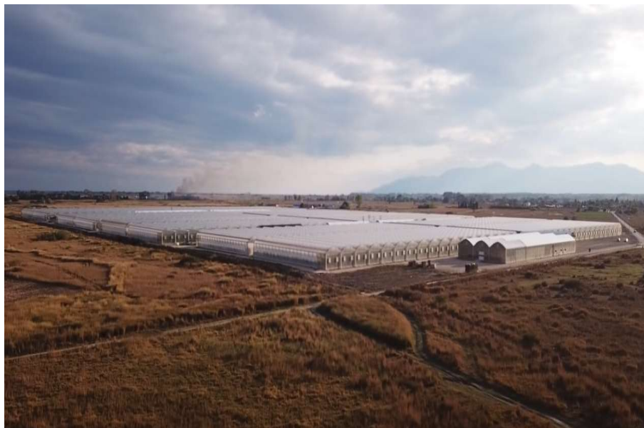
Εικόνα 1.1 Θερμοκήπιο στη Θράκη όπου χρησιμοποιούν τη γεωθερμία για την παραγωγή λαχανικών [xvi]
