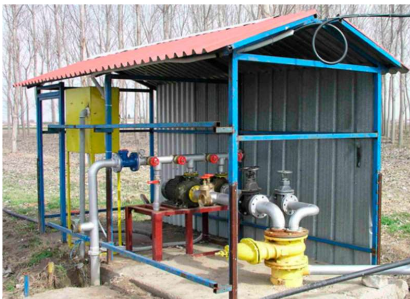
Εικόνα 4.1 Γεωτρήσεις για την άντληση γεωθερμικού ρευστού [xviii]
