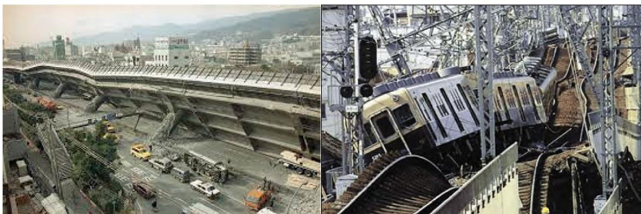
Εικόνα 2.5.1 – Εικόνες μετά τον σεισμό του Χάνσιν
