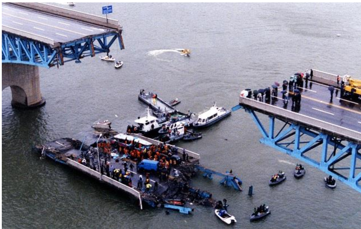
Εικόνα 2.4.1 – Το κατεστραμμένο κομμάτι της γέφυρας Seongsu
