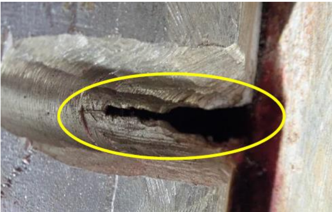
Εικόνα 2.9.3 – Εσωτερική ρωγμή και η ζώνη κόπωσης
