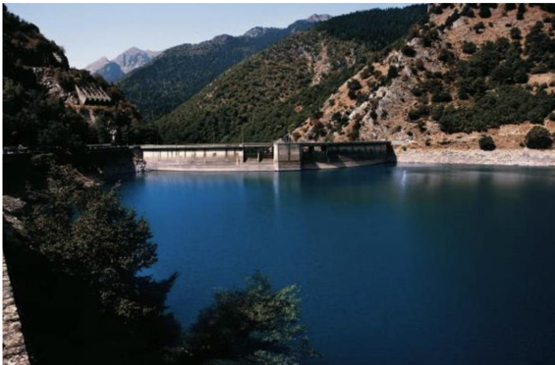
Εικόνα 6: Άλλη άποψη του φράγματος του Ταυρωπού (Πηγή: http://moucha.gr/limni-plastira-fragma.html , Ανάκτηση: 29.05.2022).
