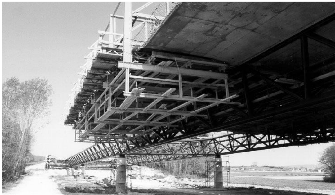
Εικόνα 1.3 Δικτύωμα σε γέφυρα
