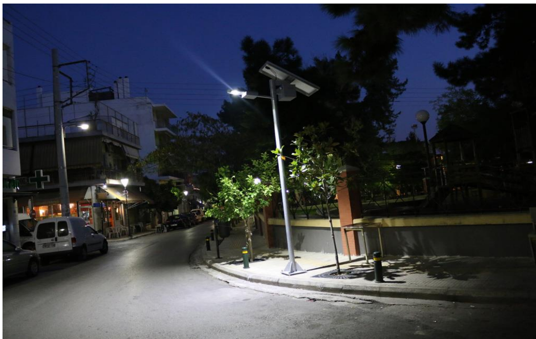
Εικόνα 8. Φωτιστικό δρόμου LED με φωτοβολταϊκό πάνελ στην κορυφή. Πηγή: techlumen.gr
