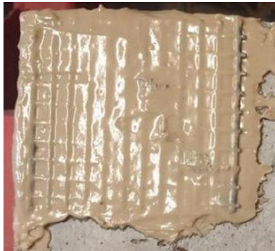
Σχήμα 3.3 Εφαρμογή κονιάματος μαζί με ινόπλεγμα πάνω σε μια επιφάνεια σκυροδέματος (ΚΑΡΑΜΠΕΛΑ Χ. 2021)
