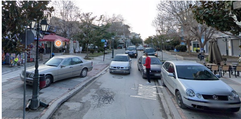
Εικόνα 11: Παράνομες σταθμεύσεις σε πεζοδρόμια και ράμπες ΑμεΑ στην οδό Λαμίας
