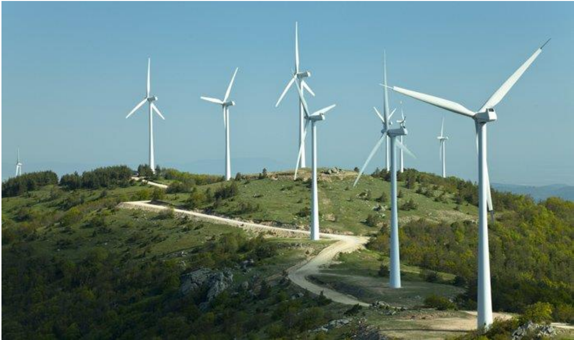
Εικόνα 5.10: Αιολικό πάρκο με ανεμογεννήτριες οριζοντίου άξονα. [58]
