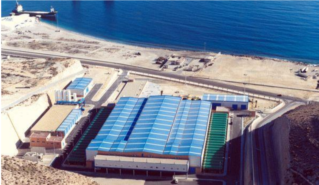
Εικόνα 6.1: Εγκατάσταση αφαλάτωσης στο Καρμπονέρας της Ισπανίας. [45]
