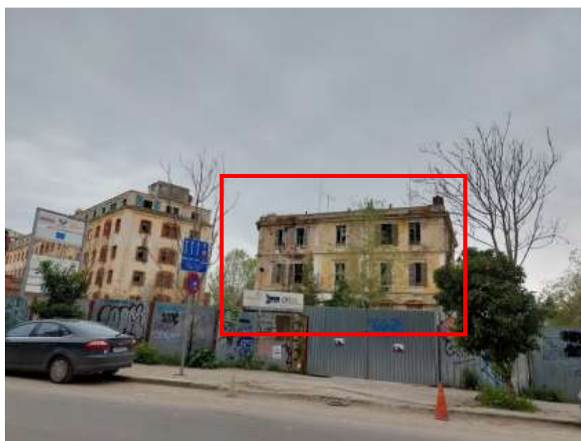
Εικόνα 6.2.1: Το κτίριο της Ζώνης Α που θα διατηρηθεί
