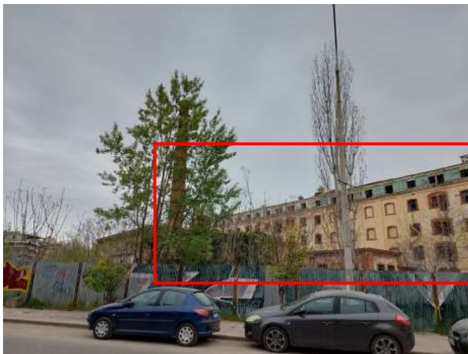
Εικόνα 6.2.2: Το κτίριο 1 της Ζώνης Β που θα διατηρηθεί
