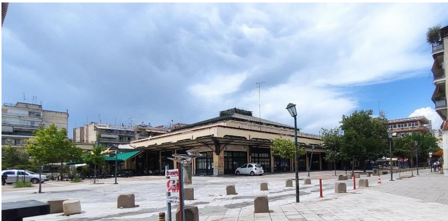
Εικόνα 3.3.4.9 Το κτίριο της Δημοτικής Αγοράς (Πηγή Ιδία λήψη)
