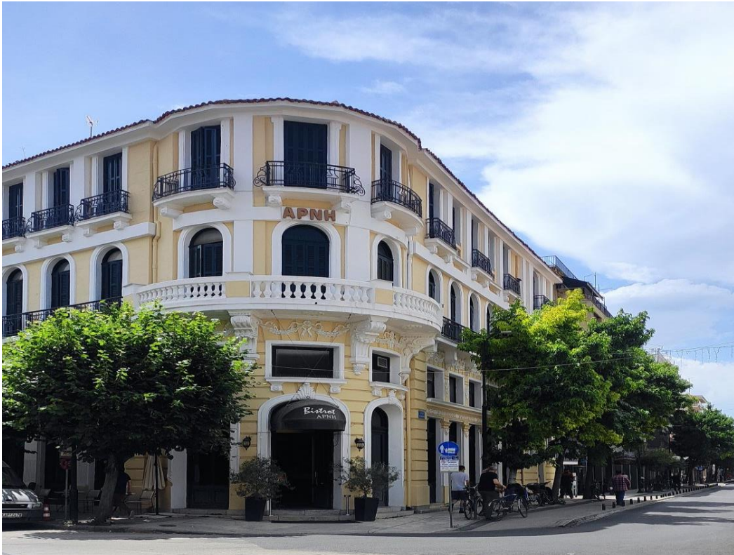
Εικόνα 3.3.4.4 Εικόνα Το ξενοδοχείο «Αρνη» (Πηγή Ιδία λήψη)
