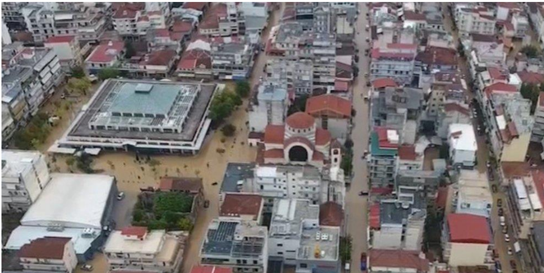
Εικόνα 4.1.1 Η επόμενη ημέρα της πλημμύρας στην Καρδίτσα (Πηγή https://www.iefimerida.gr/ellada/binteo-karditsa-plimmyrise-i-poli-kakokairia )
