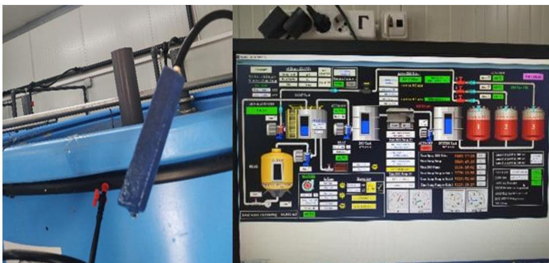
Εικόνα 15: Σύστημα αερισμού με αερόπετρες (Αριστερά). Φύλλο λογισμικού ελέγχου συστήματος ιχθυοκαλλιέργειας (Δεξιά).
