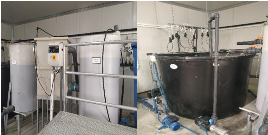
Εικόνα 14: Δεξαμενές ‘Buffer’ και ‘Biofilter’ και μηχανικό φίλτρο (Αριστερά). Καθαρή δεξαμενή (Δεξιά).
