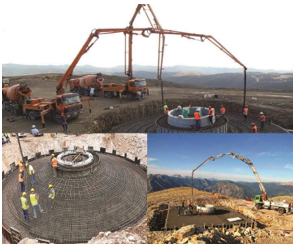
Εικόνα 5.1:Στάδια κατασκευής ανεμογεννήτριας
