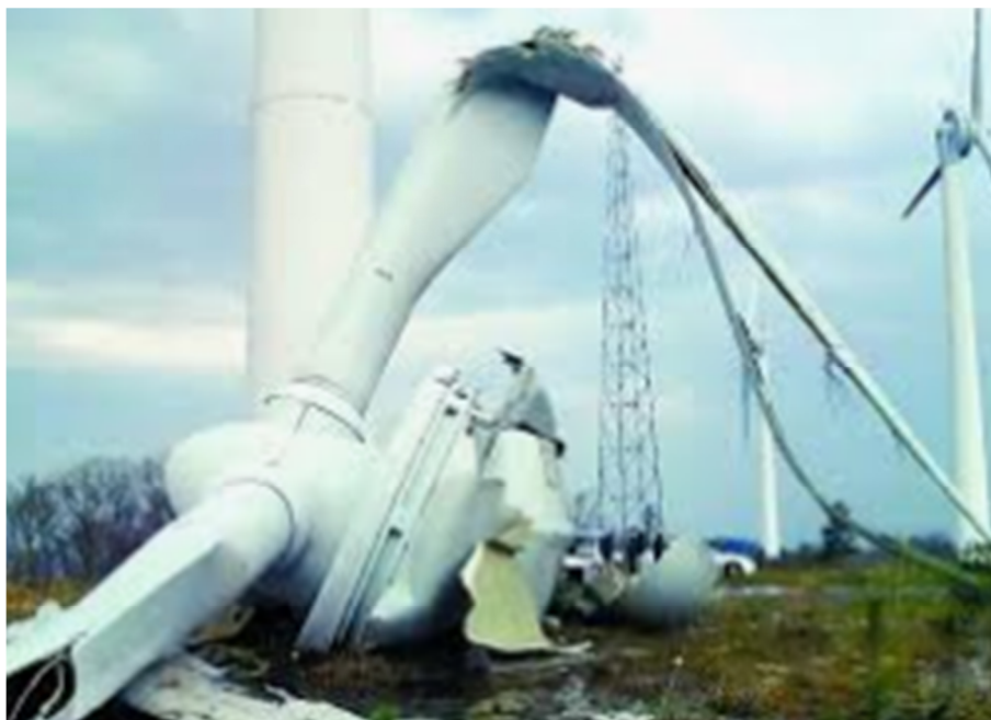
Εικόνα 4.6: Ανεμογεννήτρια που έχει υποστεί λυγισμό
