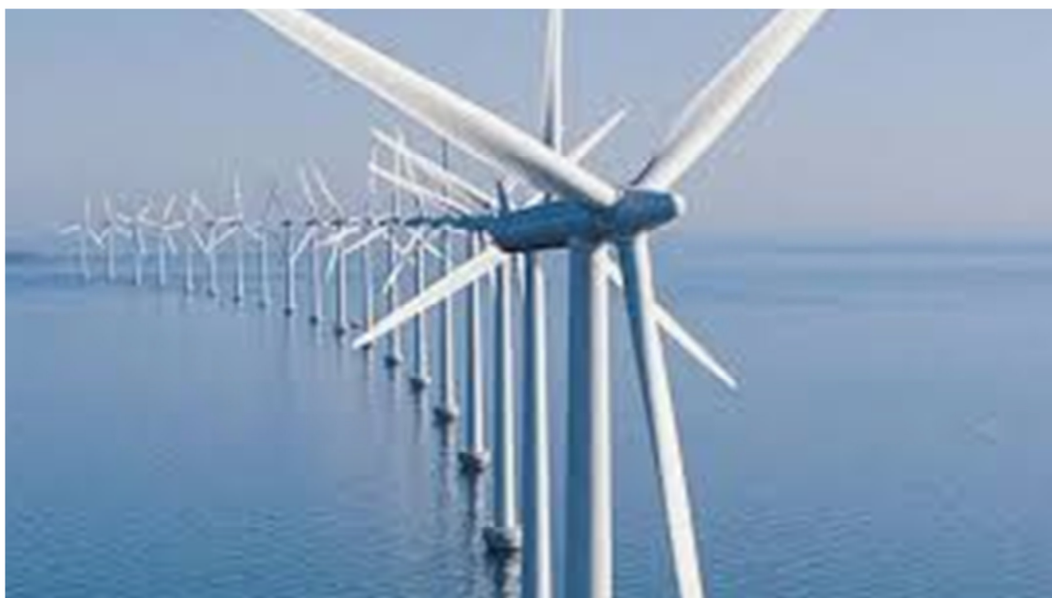
Εικόνα 4.2: Μεγάλο Υπεράκτιο Αιολικό πάρκο στη Δανία (Χατζημπίρος, 2014).
