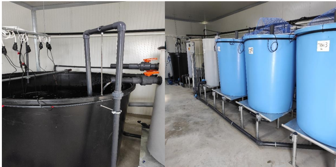
Εικόνα 12. Δεξαμενή συλλογής νερού για την χρήση του από την κεφαλή υδρολίπανσης (Αριστερά). Απεικόνιση του συστήματος ιχθυοκαλλιέργειας (Δεξιά).
