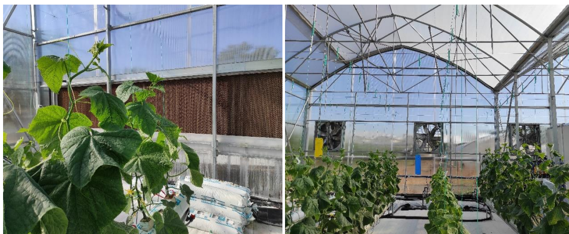
Εικόνα 6. Συστήματα δροσισμού του θερμοκηπίου (αριστερά η υγρή παρειά και δεξιά οι ανεμιστήρες).
