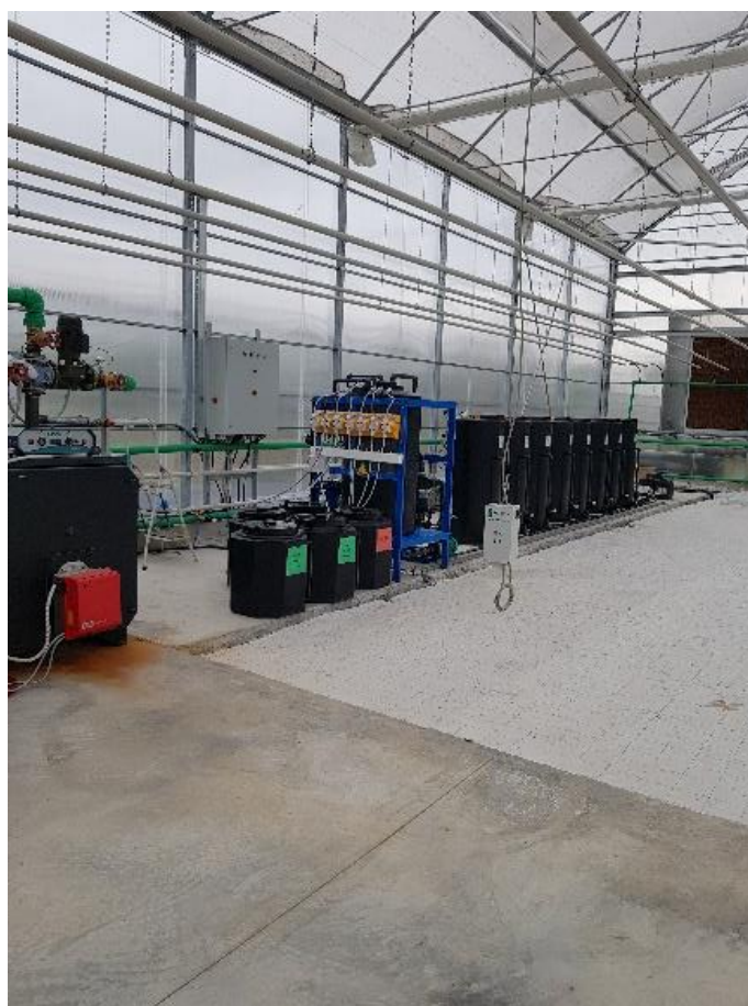
Εικόνα 1. Απεικόνιση του συστήματος υδρολίπανσης του υδροπονικού συστήματος του θερμοκηπίου
