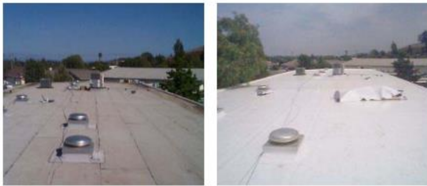
Εικόνα 5.2.2.8: Εκ νέου Επίστρωση Μεμβράνης Λευκού PVC (Πηγή: Akbari et al., 2005).
